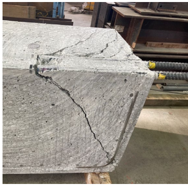
(a) Case-5 コーン状のひび割れ
