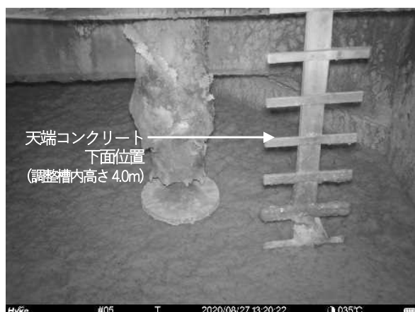
図-37 調整槽内部 (2020/8/27 13:20)
