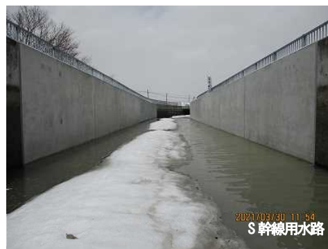
図-67 実証試験現場の状況
