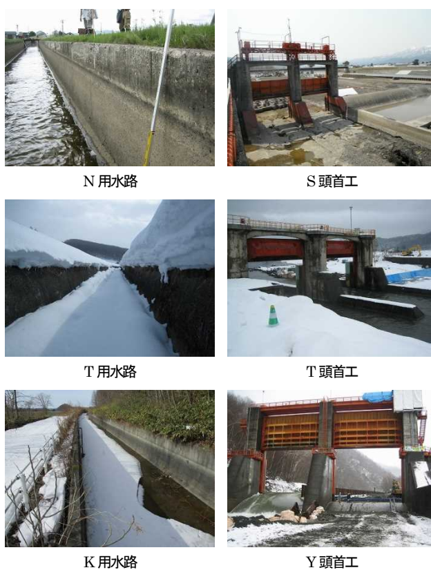
図-1 詳細調査の対象としたコンクリート施設の現況
