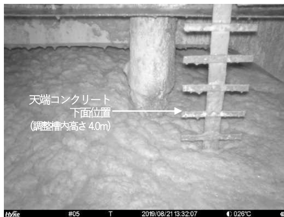
図-31 調整槽内部(2019/8/21 13:32)
