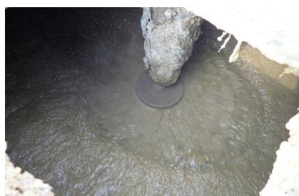
図-3 稼働中の消泡機
