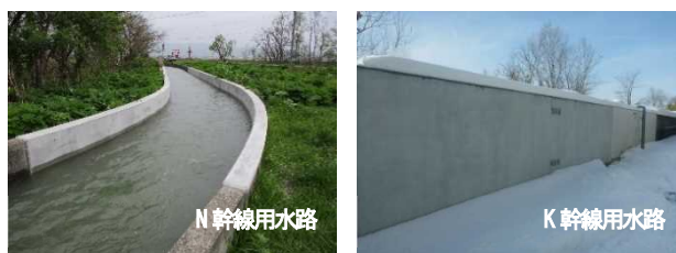
図-66 試験施工現場の状況
