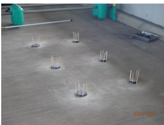
(a) 横浜ベイブリッジの固定状況
