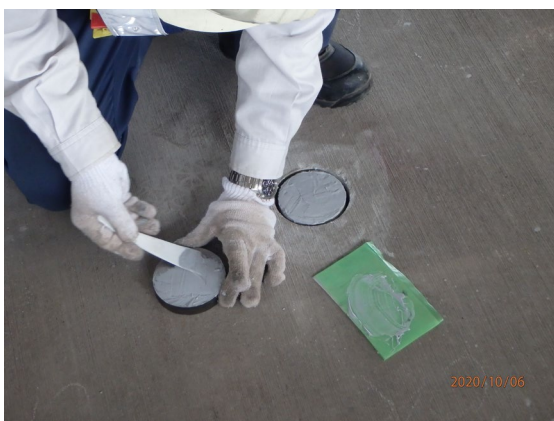
写真-4.2.6 治具用接着剤の塗布状況
