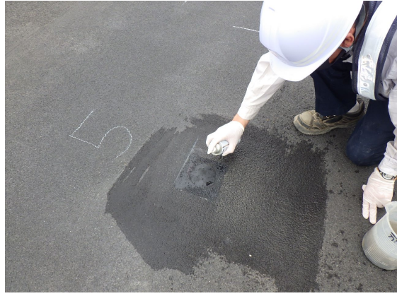
写真-4.2.14 スプレーによる施工
