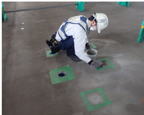
写真-4.2.11 モルタルの充填状況
