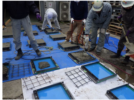
写真-2.1.8 振動機による施工 (⑦)
