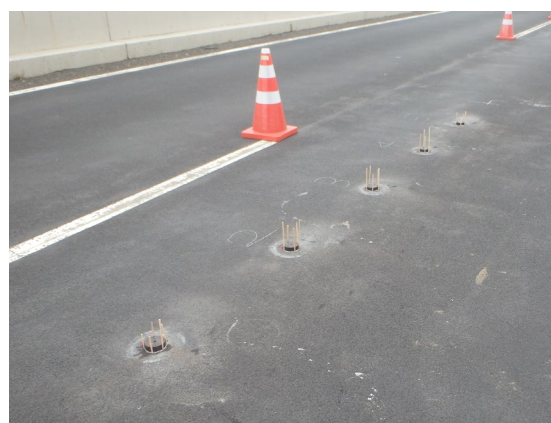
(b) 大平高架橋の固定状況
