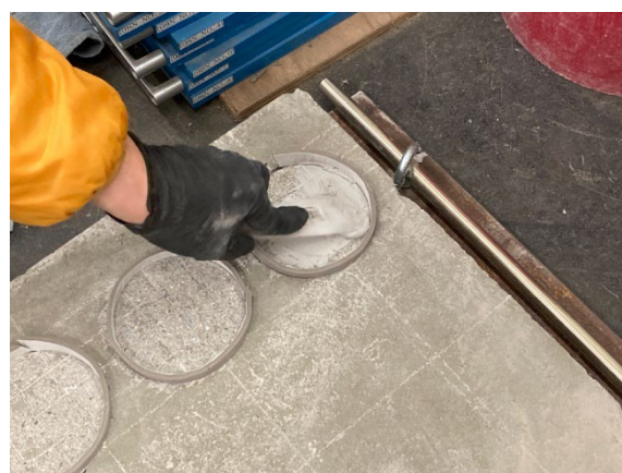
写真-2.1.22 間詰材の仮設置
