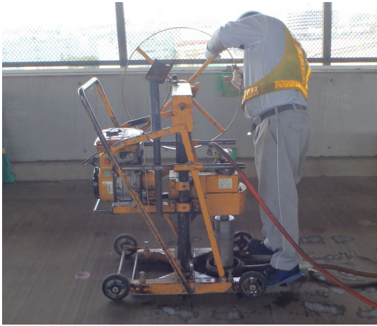
写真-4.2.2 手押しの切削機械
