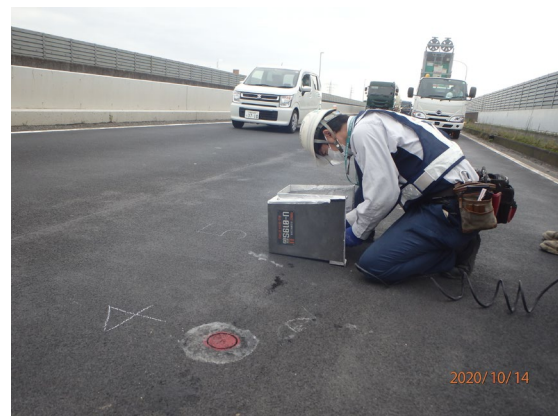
(b) 大平高架橋の研掃状況
