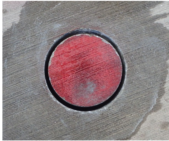
写真-4.2.3 切削状況（横浜ベイブリッジ）
