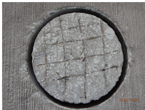
写真-4.2.5 ディスクグラインダにより格子状に切り込みを設けた状況
