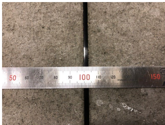
写真-2.1.12 カッターにより導入した 模擬貫通ひび割れ (3mm 幅)
