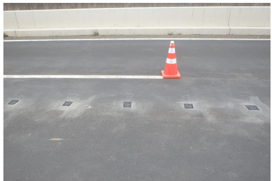
(b) 大平高架橋
