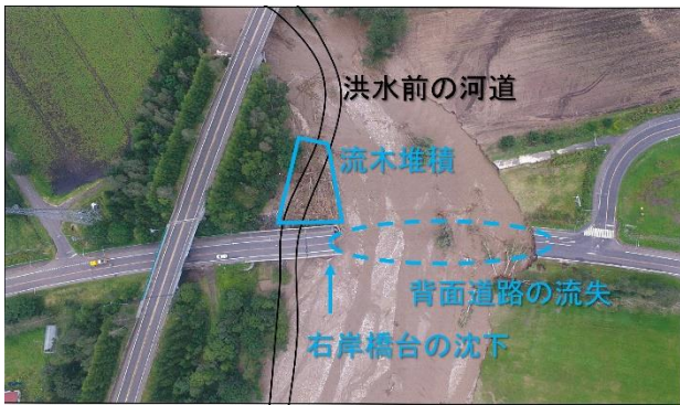
写真-1 小林橋周辺被災状況の詳細
