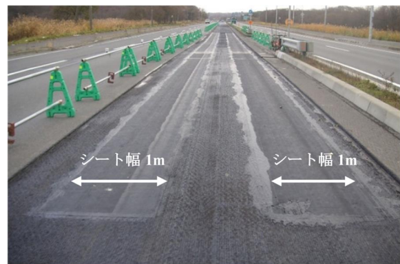
写真-2.1.1 ひび割れ抑制シート貼付後の状況
