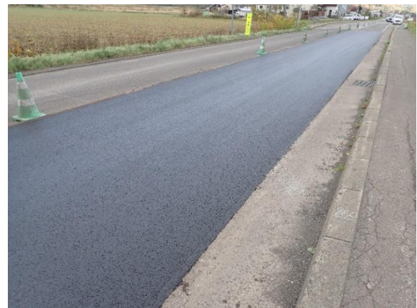
写真-2.2.4 一般国道 276 号倶知安町の施工後の路面状況
