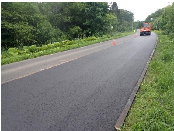
写真-2.2.3 一般国道 44 号厚岸町の施工後の路面状況
