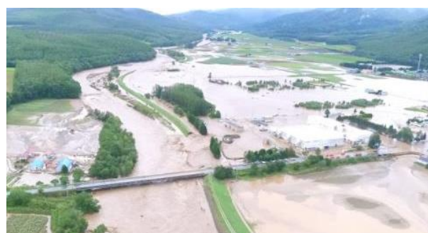
空知川での堤防決壊（国土交通省北海道開発局提供）
