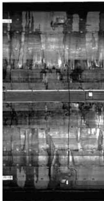
図 3-77 壁面画像を貼り合わせた展開画像
