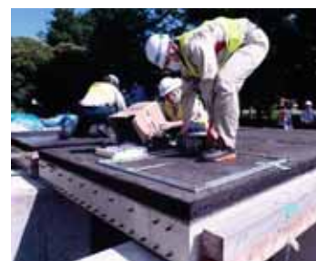
写真 1-6 超音波探査
