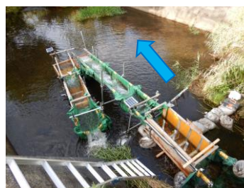
図-8 余市中の川二号床固工における形状可変型布製簡易魚道。2019年に設置された直線型(a)、2020年に設置された折り返し型(b)魚道
