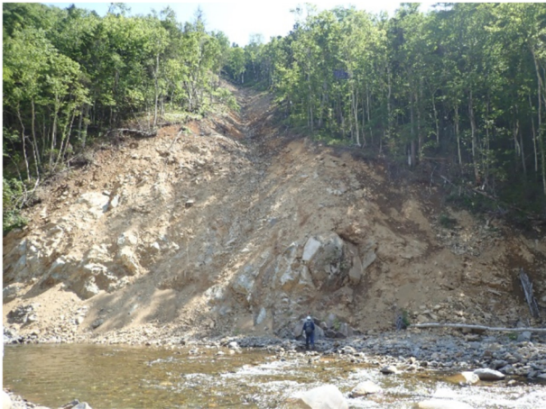
写真-1 対象流域の植生と裸地
