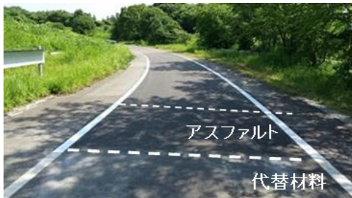
写真-1 舗装走行実験場に施工した提案技術
