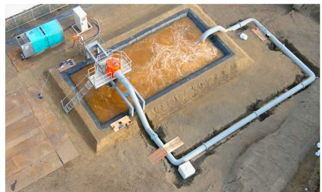
写真-4 試験装置の仮設状況
