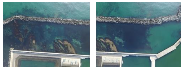
写真-2 ドローン撮影した二重堤間の空撮写真(一部)
