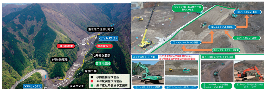
図-6.1-2 3号砂防堰堤工事概要
