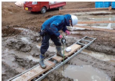
図-4.6-4 コーンペネトロメータによる測定
