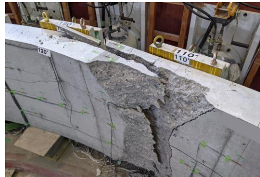
写真-1 薄肉高強度覆工の肩部の状態
