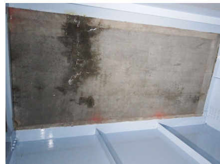
(b) 点検技術者によって二方向と評価されたひび割れ
