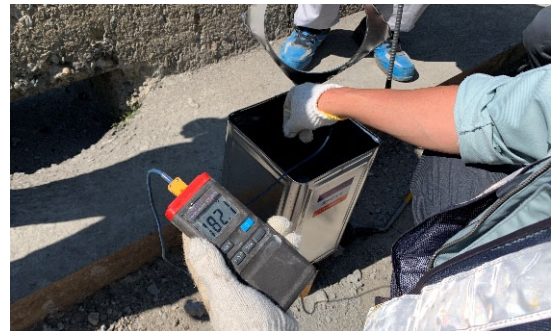
写真-4.7 瀝青系目地材の加熱
