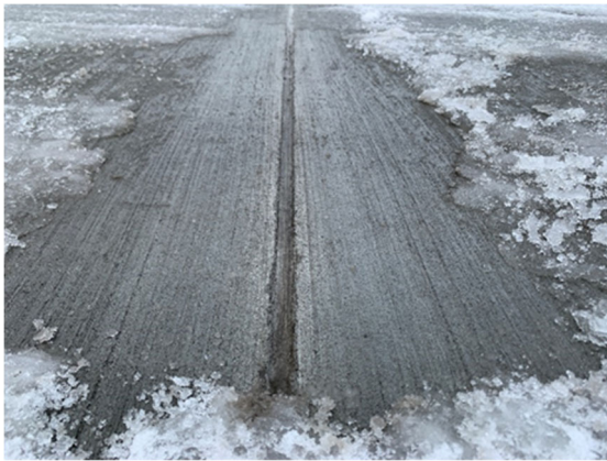
写真-4.18 施工から半年経過後（冬期）の目地の状況
