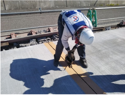
写真-4.8 瀝青系目地材のやかん注入
