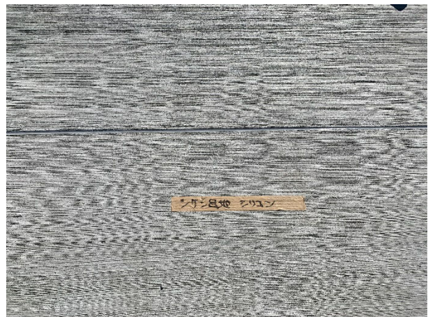
写真-4.13 シリコン目地仕上げ状況
