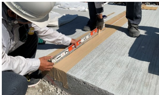
写真-4.10 バックアップ材（設置（深さ2cm）
