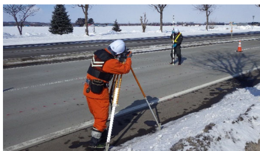
写真-3.9 レベル測量による凍上量測定
