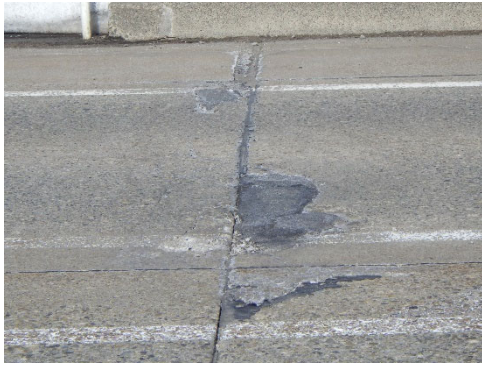
写真-4.1 アスファルト混合物での措置
