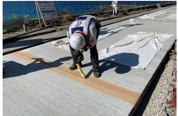
写真-4.12 シリコン系目地材注入状況
