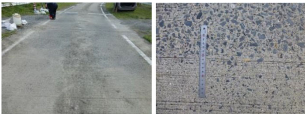
写真-3.7 工区2のポリッシング (左: 全景、見目: 近景)
