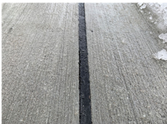
図-4.15 施工から半年経過後（冬期）の目地の状況
