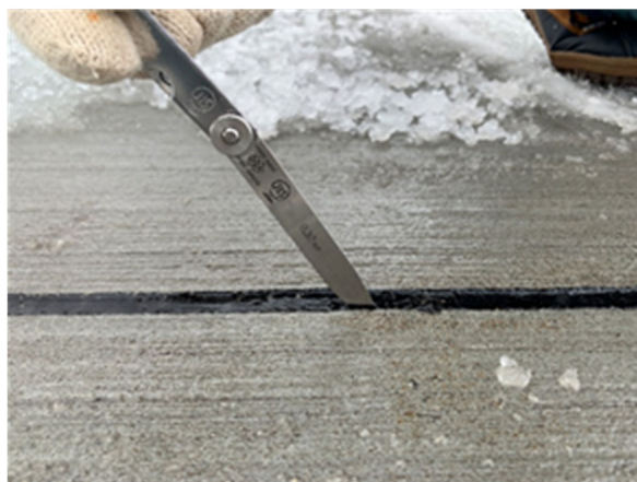
写真-4.16 施工から半年経過後（冬期）の目地の状況
