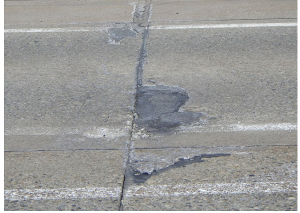
写真-2.1.2 発生したひび割れおよび角欠けと補修後の状況（右）
