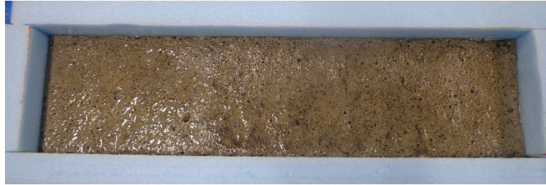
写真-3.1.4 エポキシ系プライマー塗布
