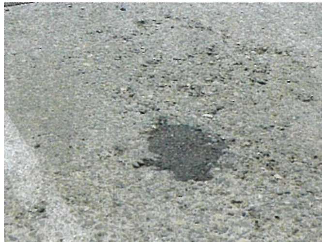
写真-2.1.1 ポットホールの補修 2) (アスファルト混合物で補修)
