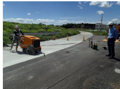
写真-4.3.2 舗装切断状況
