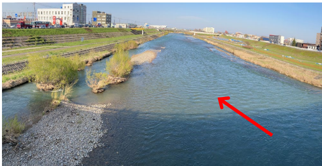
写真-4 東橋下流の砂州前縁部 (R3年4月下旬) 融雪出水時
