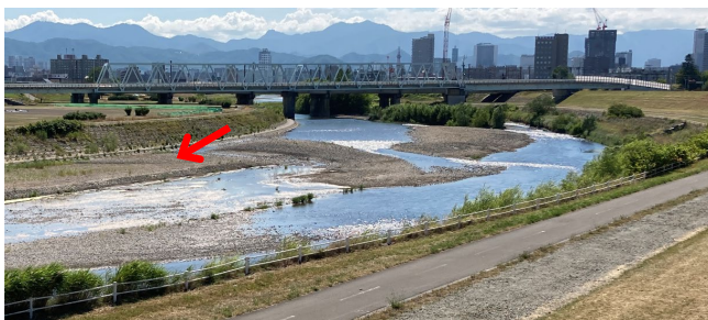
写真-8 2次掘削1年後の河道状況 (JR橋下流、R3年7月)
