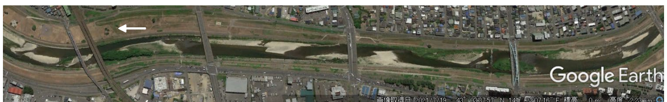
写真-6 掘削1年後の状況 (2021年)
