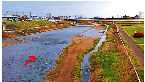
写真-3 掘削直後の河道 (東橋から下流側を望む、R2年11月)
