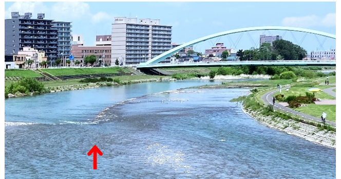
写真-9 一条大橋下流の砂州の冠水状況 (R2年9月砂州切下げ、撮影R3年5月(上))
