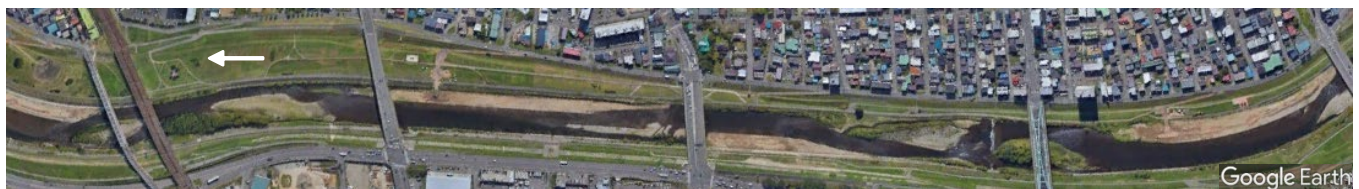
写真-5 掘削直後の状況 (2020年)
