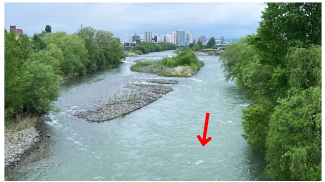
写真-7 南大橋上流の中島合流部 (R3年5月) 融雪出水時
