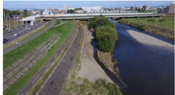
写真-1 alcove 上流端へ続く掘削水路（2017/9/26 撮影）
