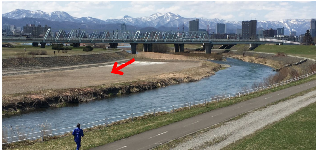
写真-7 1次掘削後の河道状況 (JR橋下流、R2年4月)
