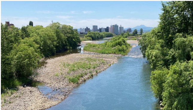
写真-6 南大橋上流の中島合流部 (R3年6月)
