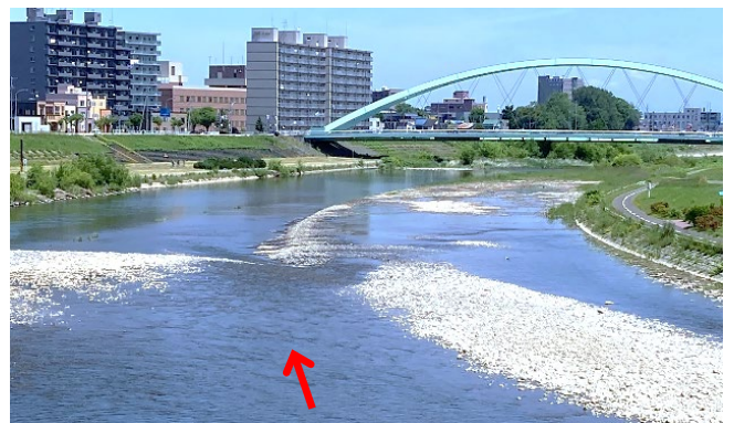
写真-10 一条大橋下流の砂州の冠水状況 (撮影R3年6月(下))
