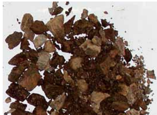
写真-4.2 細かい粒子が多くなる砕石の劣化状態
