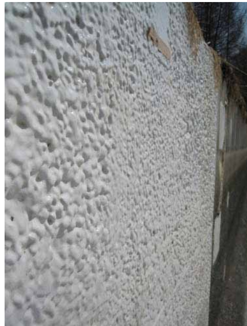
写真-3.3 劣化部除去後のウレタン樹脂直接塗布
