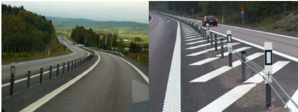
図-3.13 ワイヤロープ式防護柵(スウェーデン)
