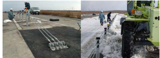
図-3.15 試験施工と除雪作業に伴う支柱への影響の確認
