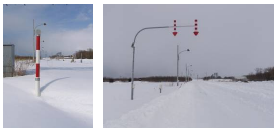
写真-5.2 視線誘導施設の設置状況
