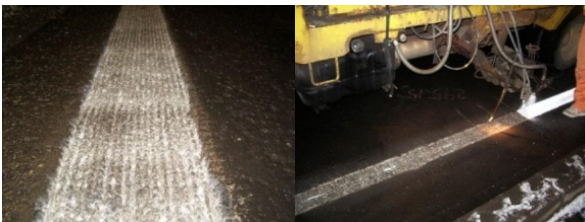
図-3.9 切削型区画線の施工状況
