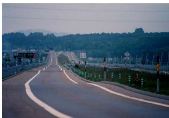
写真-2.1 供用4年目の路面沈下 (上：粘土地盤、下：泥炭地盤)
