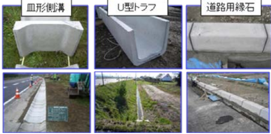
図-4.4 試作した製品の概要と敷設状況
