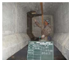
写真-4.2 塗布状況
