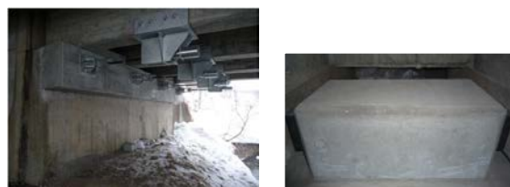
写真-4.6 変位制限構造への適用 (PVA 普通コン)
