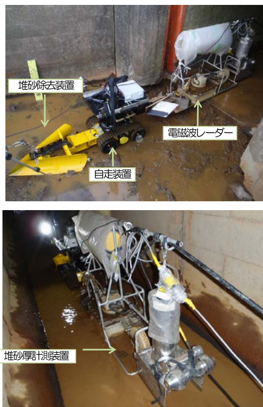
写真-2.2 実樋門試験状況 (上：粘土地盤、下：泥炭地盤)
