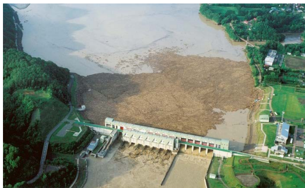
図-6.1 2003年8月沙流川出水時の二風谷ダム
