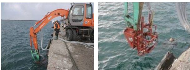
写真-5.6 点検装置による測定
