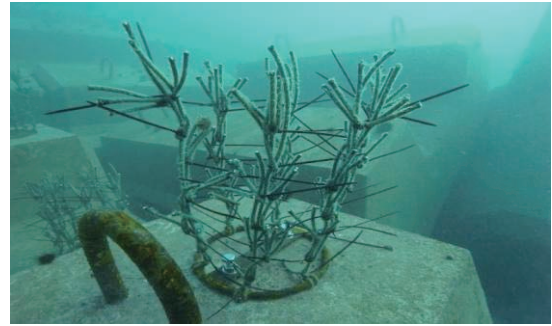
写真-4.2 人工海藻の設置状況 2009年11月25日
