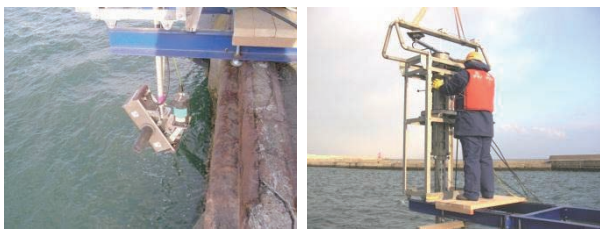
写真-5.7 計測用架台
