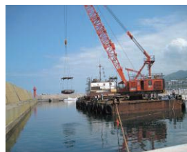
④ 貝殻礁の据付
