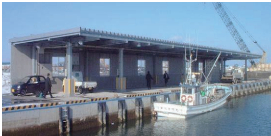
図-2.1 港内防風雪施設の例（大津漁港）
