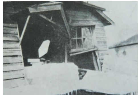
図-3.18 流氷を伴った津波による被害例
