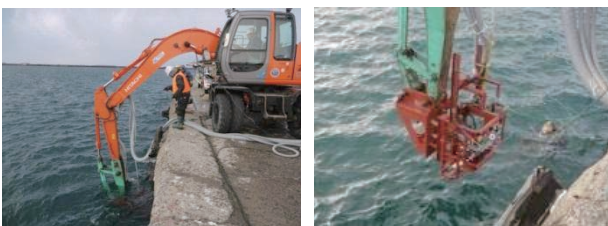
写真-5.6 点検装置による測定
