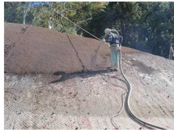
写真-5.4 施工時の状況
