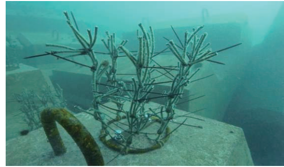
写真-4.2 人工海藻の設置状況 2009年11月25日
