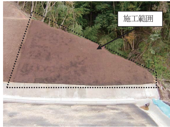
写真-5.5 施工完了時の状況
