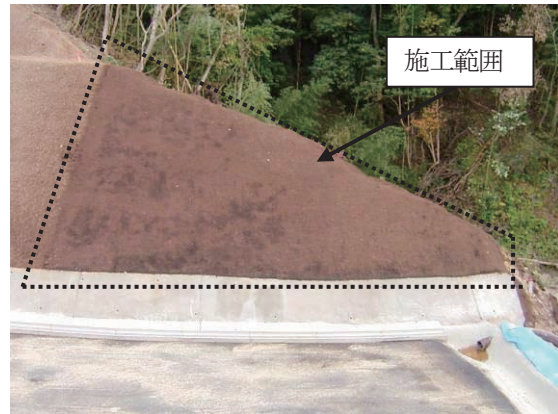
写真-5.5 施工完了時の状況
