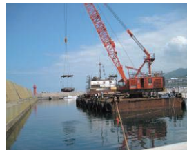
④ 貝殻礁の据付
