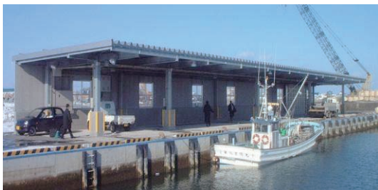
図-2.1 港内防風雪施設の例（大津漁港）
