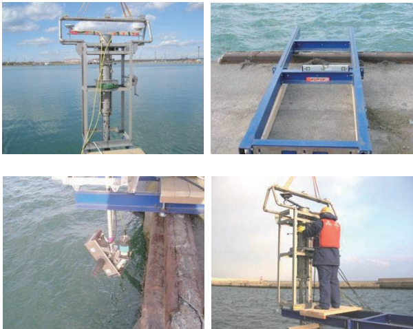
写真-5.7 計測用架台
