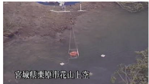
図 5.3.3 投下型水位観測ブイとその設置状況 (国土交通省東北地方整備局提供)
