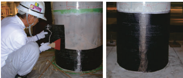
(b) 修復作業の様子と復旧後の柱基部 図-7.1 速乾性材料を用いたCFS巻立て工法
