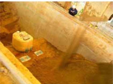
写真4.2.56 覆土実験 投入2回目状況
