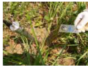
写真 4.1.19 単管打設型地上設置タイプ (ID:1A1) 設置状況
