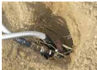
写真 4.1.9 埋設型設置状況
