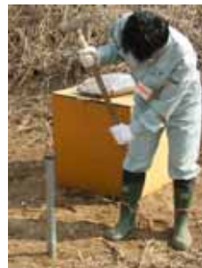
写真 4.1.10 単管打設状況
