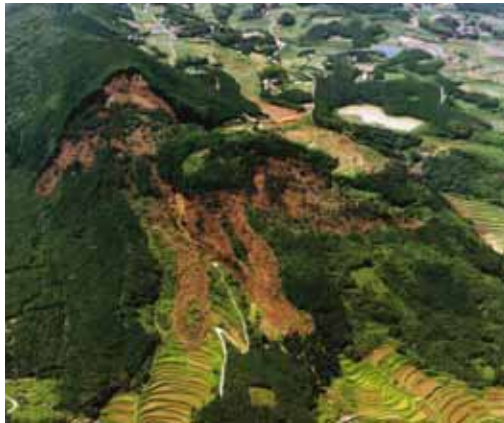
写真 3.1.1 新第三紀層泥岩地すべりタイプ（石倉地区） 2)
