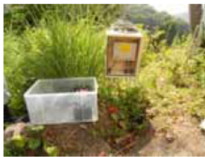
写真 4.1.18 データロガー及びバッテリー設置状況
