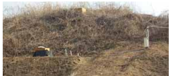
写真 4.1.13 設置盛土全景
