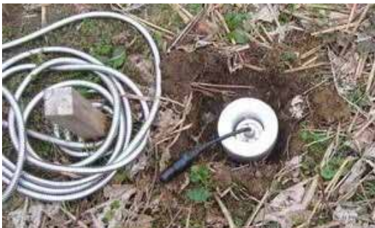
写真 4.1.17 単管打設型断熱材設置タイプ設置状況
