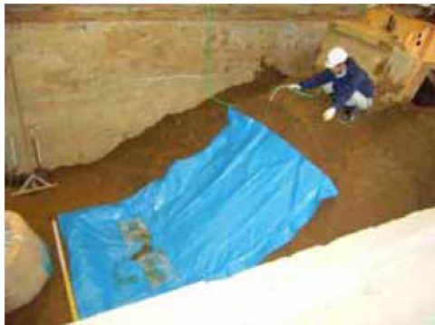
写真4.2.59 湧き水実験注水開始状況
