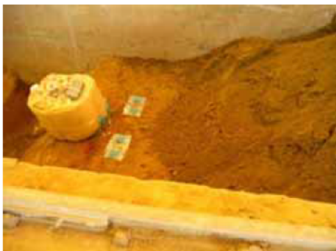
写真4.2.55 覆土実験 投入1回目状況
