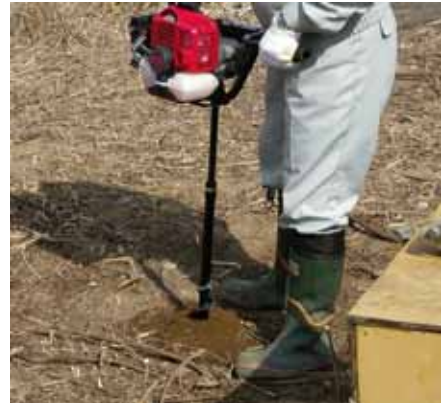
写真 4.1.8 オーガーボーリング状況
