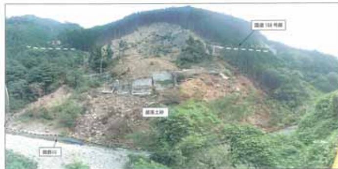
写真 3.1.3 岩盤崩壊性地すべりタイプ（宇井地区）
