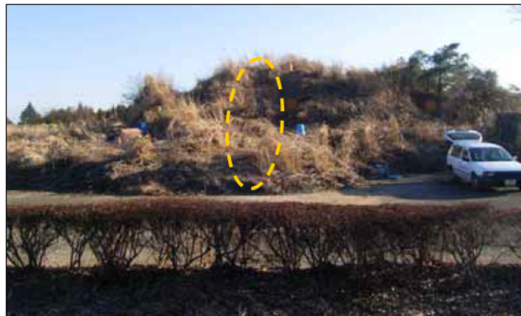
写真 4.5.6 土工実験場 全景
