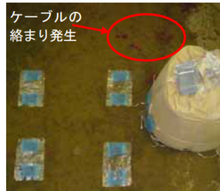
写真4. 2. 53 シート型センサ設置状況
