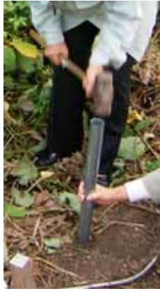
写真 4.1.14 単管打設状況
