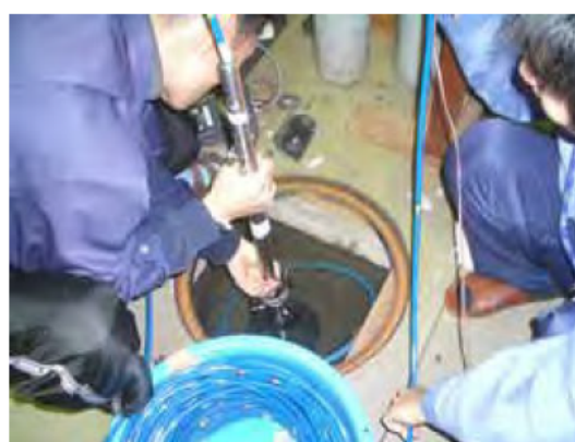
写真 3. 8 連続注水測定実験の状況
