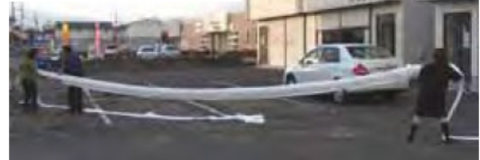
図 4.26 パッカーの補強
