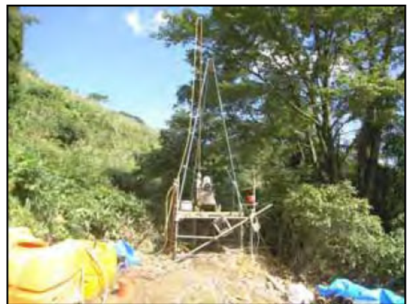
写真 4.15 掘削状況全景
