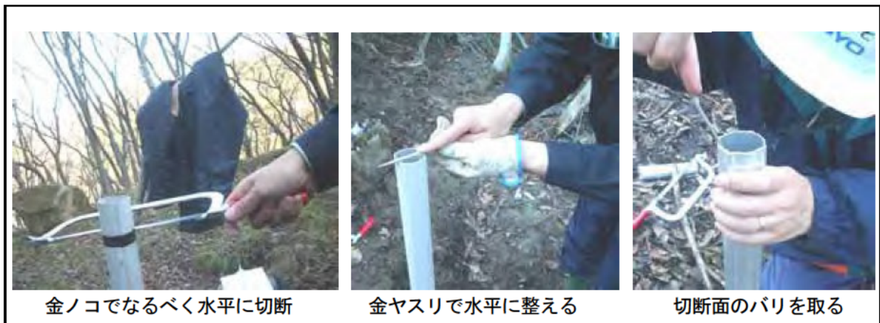
写真 4.6 ガイド管の切断作業
