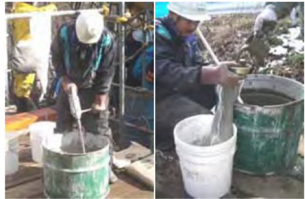
写真 4.4 充填材の攪拌状況
