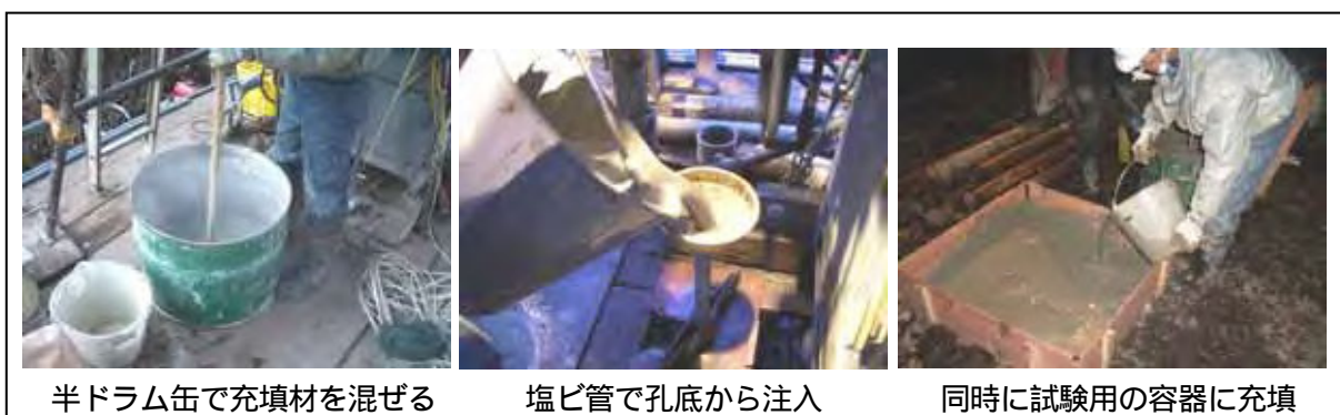
写真 4.7 充填材の作成と充填作業状況
