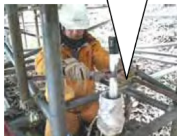
図 4.68 十字打ちと孔口方向合わせの状況
