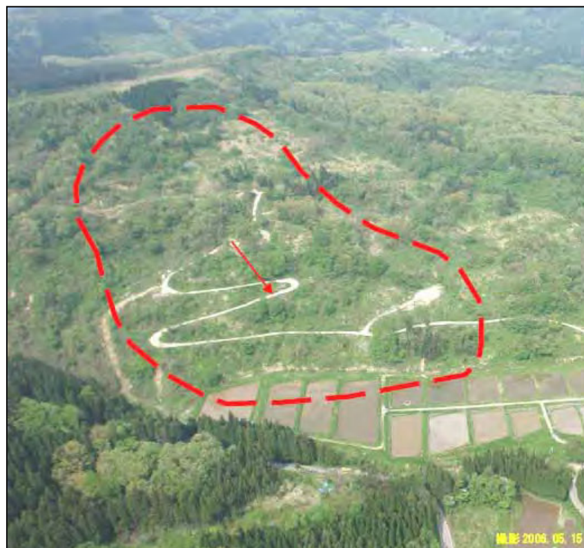
写真 4.13 胡桃地すべり B-2 ブロック全景写真
