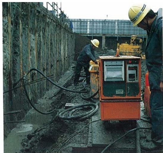
写真-III-3 加圧・膨張工
