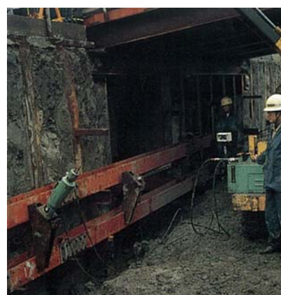
写真-Ⅲ-5 緊張・定着工
