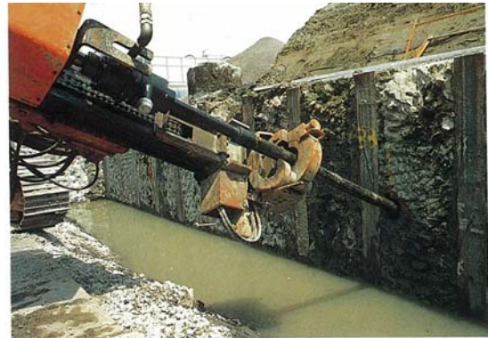
写真-III-2 打込み工
