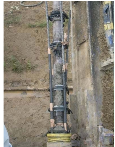
逆流防止剤引き上げ
