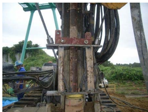
図-5.5 PC 鋼より線緊張余長部の固定
