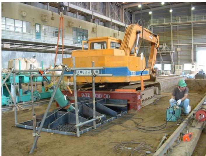
写真-2.15 引抜試験状況
