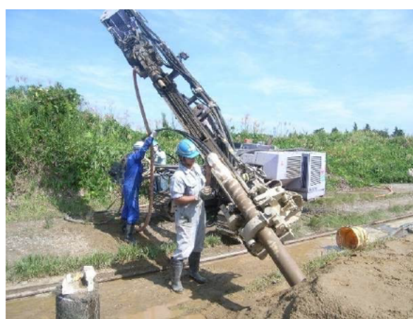
アンカー材挿入状況
