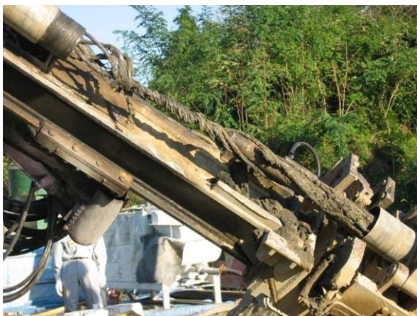
PC 鋼より線切断状態(CASE-4)
