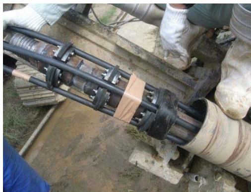
図-5.4 逆流防止装置の取付け
