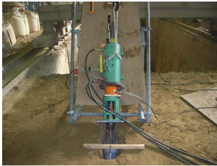
写真-2.13 スケルトン拡径状況
