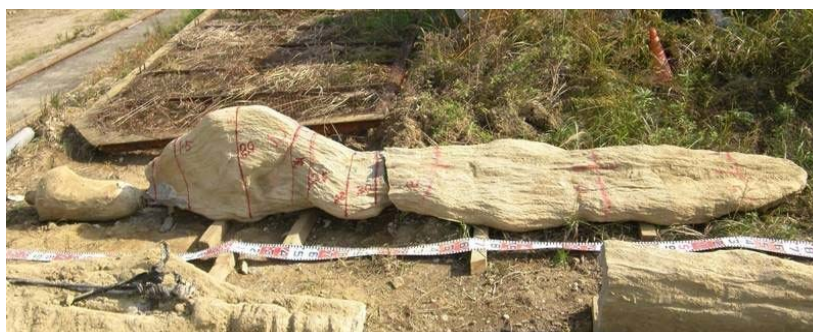
写真-3.6 アンカー体 出来形
