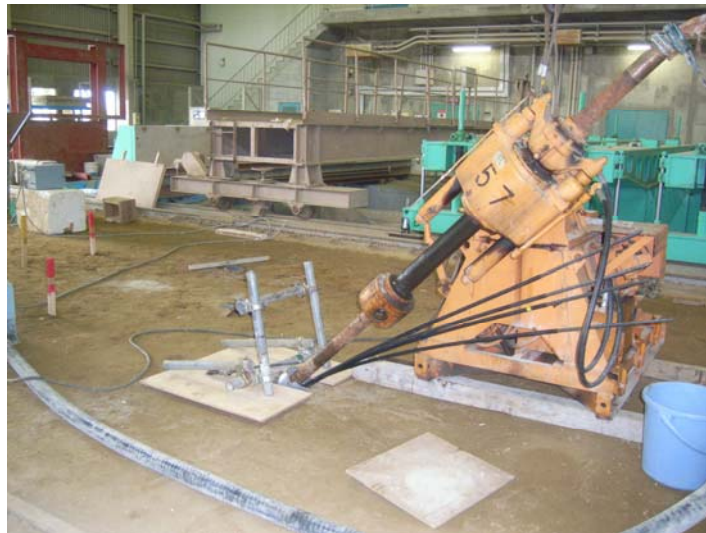
写真-2.14 注入状況
