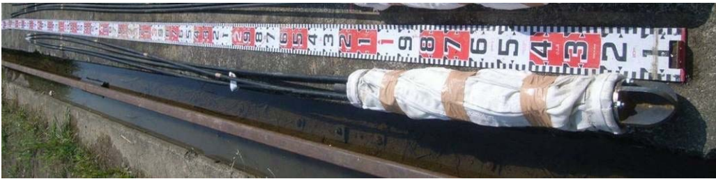
写真-3.2 袋材取付け状況
