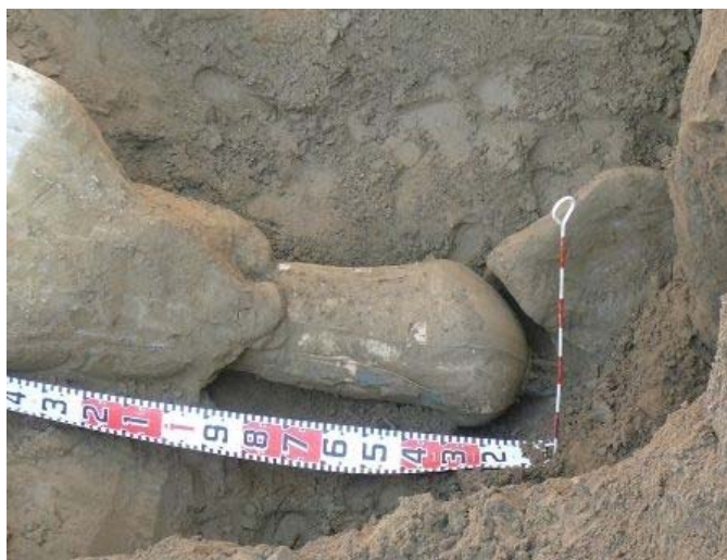
出来形 (パッカー上部接続状況)
