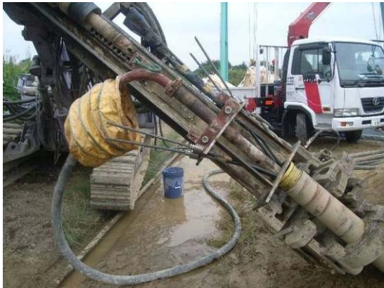
写真-3.4 注入状況
