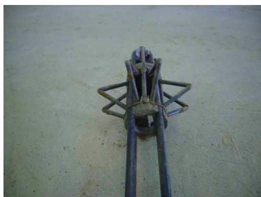
写真-2.8 ケース 4 出来形
