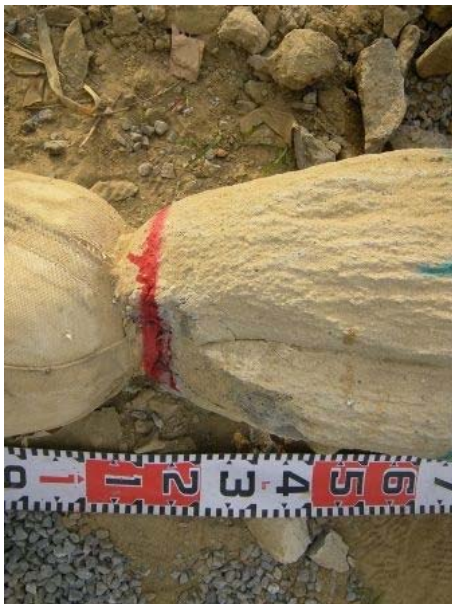
出来形(パッカー上部接続状況)
