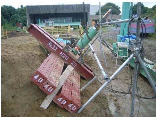
写真-3.5 引抜試験状況
