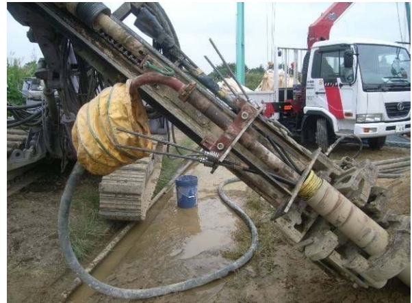
C P G材料圧送状況
