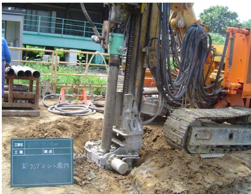
図 4.9 ボーリングマシン据付
