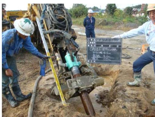
図 2.10 削工・拡径状況
