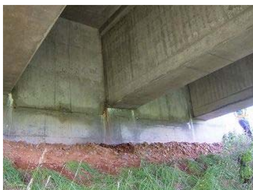
図 2.3.8 上・下部構造接合部の主桁下面の損傷
