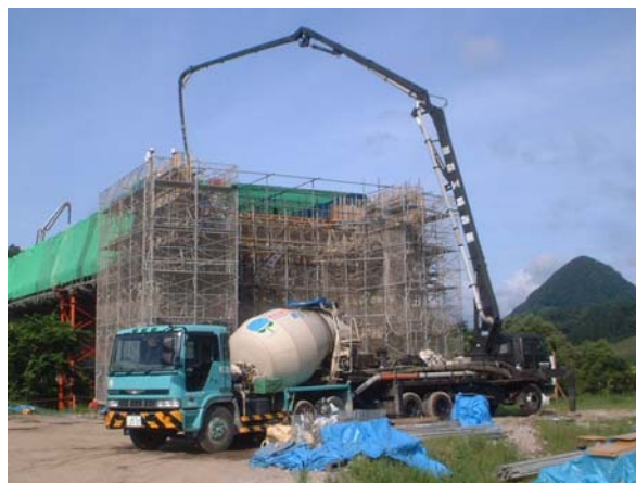
図 3.2.1 日よけ屋根設置例
