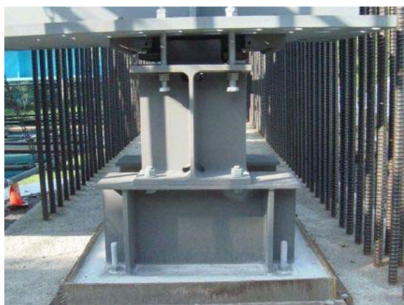
図 3.4.1 鋼上部構造の仮支承の例
