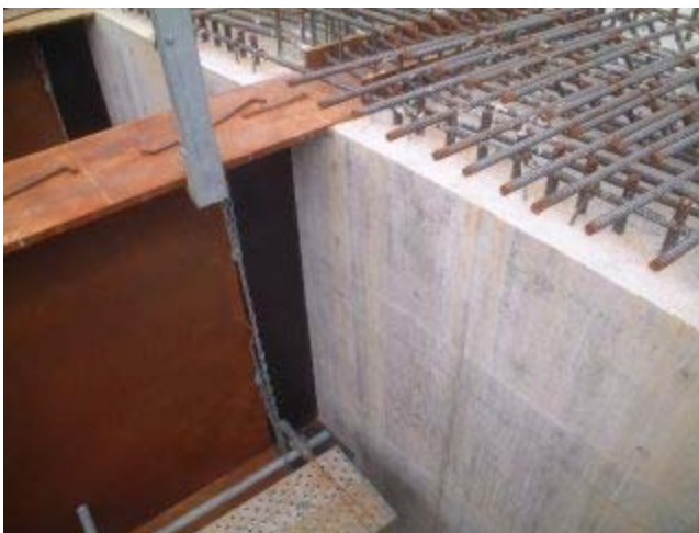
図 2.3.6 耐候性鋼材の桁端部塗装例 1
