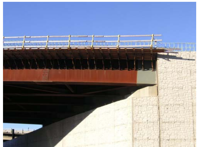
図 2.3.7 耐候性鋼材の桁端部塗装例 2
