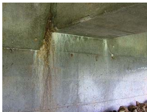
図 2.3.9 主桁下面からの遊離石灰，錆汁の析出
