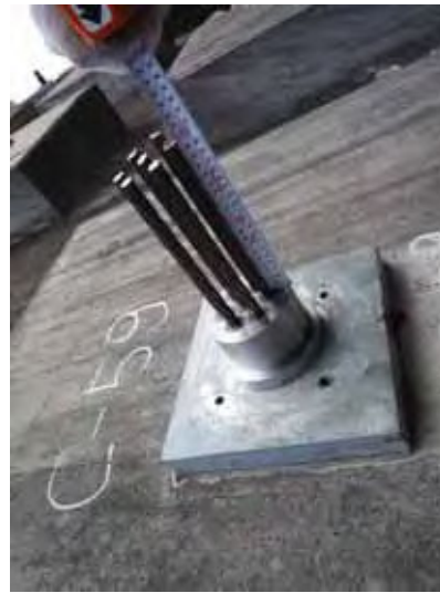
a) 荷重計取付け時 (H21.1)
