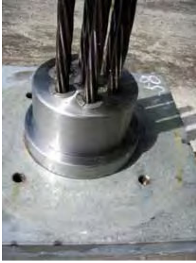
c) 現状復旧 (錆の除去) の状況 (H21.9)
