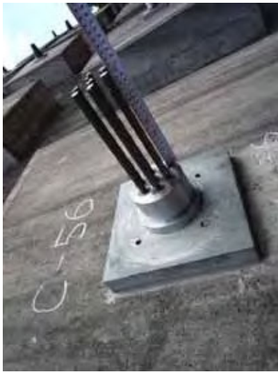
a) 荷重計取付け時 (H21.1)
