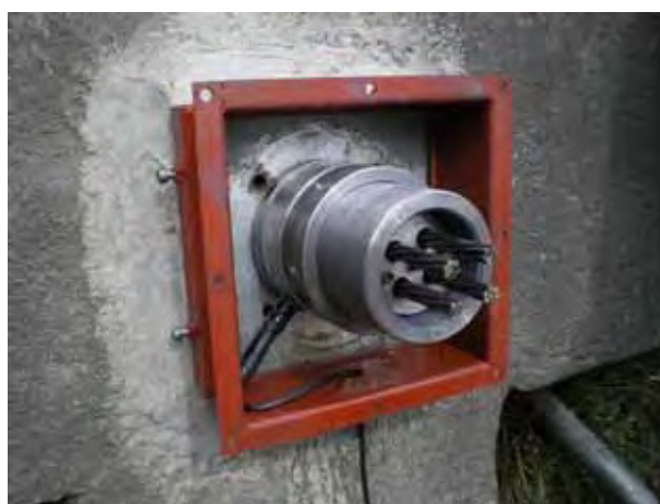
-4 テンションスリーブ、定着ナットの取付け
