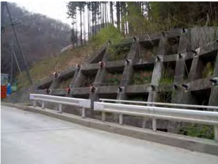
写真 10.23 試験後の法面
