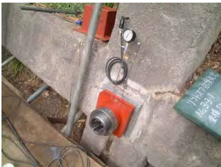
写真 10.17 荷重計取付け状況
