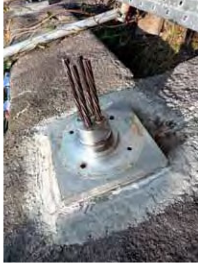
c) 現状復旧 (錆の除去) の状況 (H21.5)
