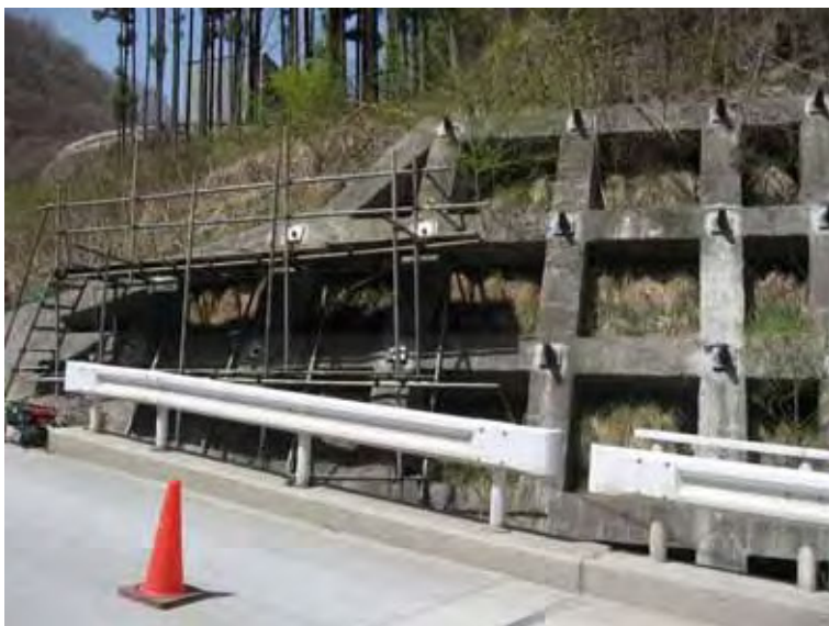
写真 10.29 作業足場の仮設
