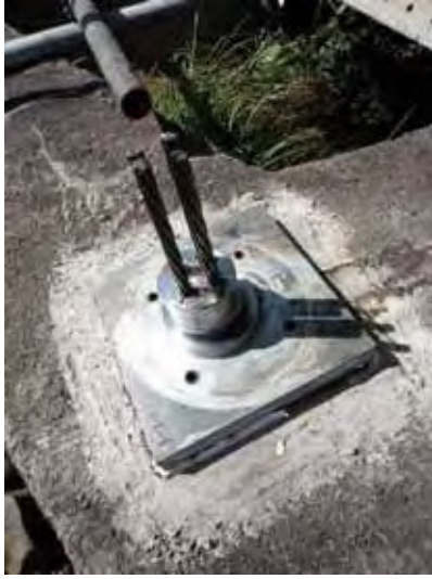
c) 現状復旧 (錆の除去) の状況 (H21.5)
