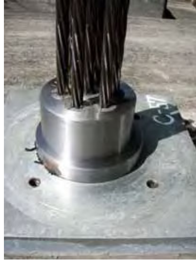
c) 現状復旧 (錆の除去) の状況 (H21.9)
