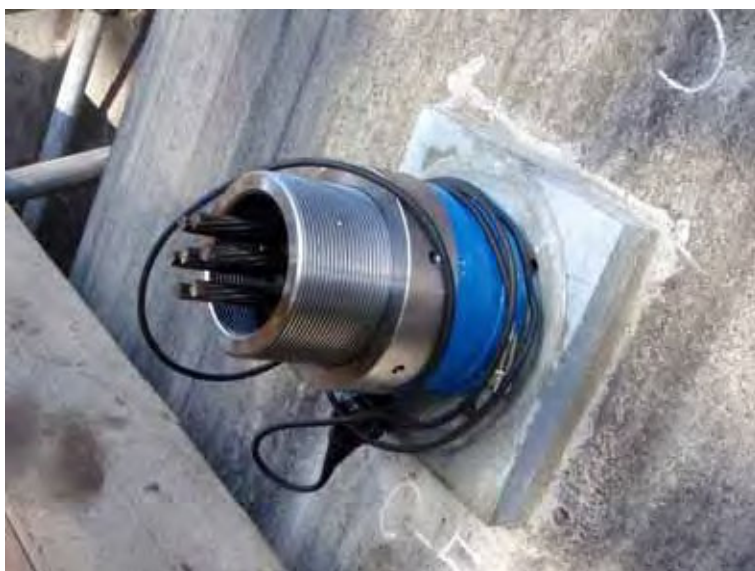
写真 10.61 荷重計取付け状況
