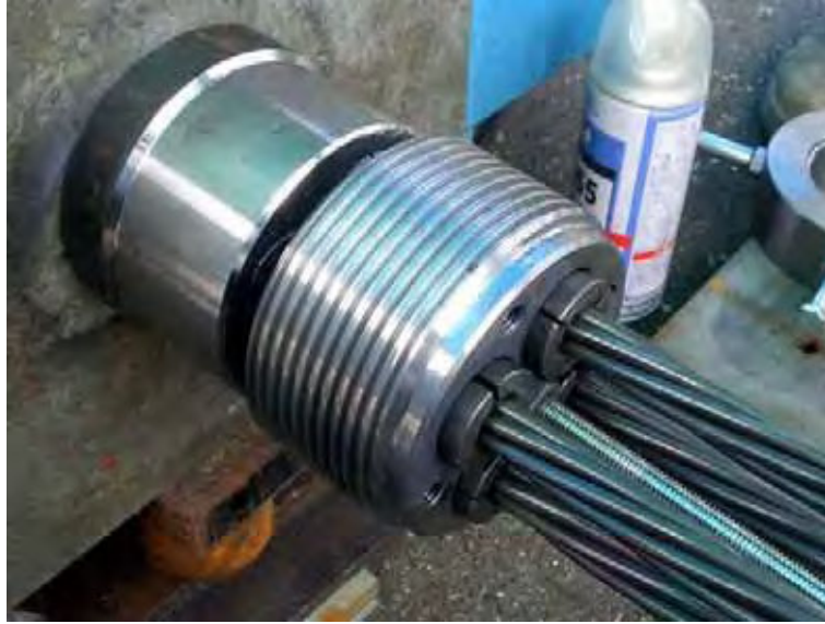
写真 11.18 ゆるくセットのくさび状態
