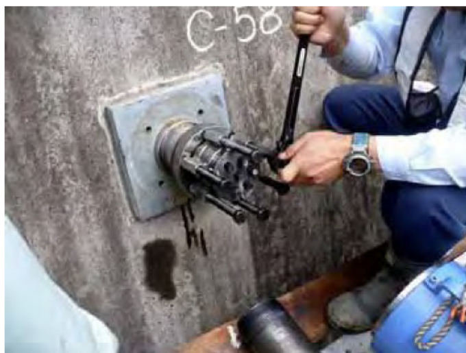
写真 10.87 ジョイントスリーブ取外し状況 (取外し治具使用)
