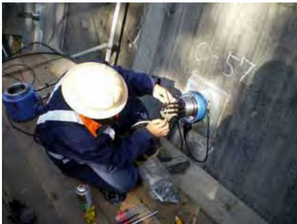
-1 荷重計、ジョイントスリーブの取付け
