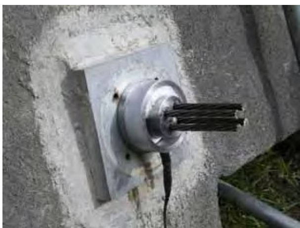
-1 荷重計の取付け
