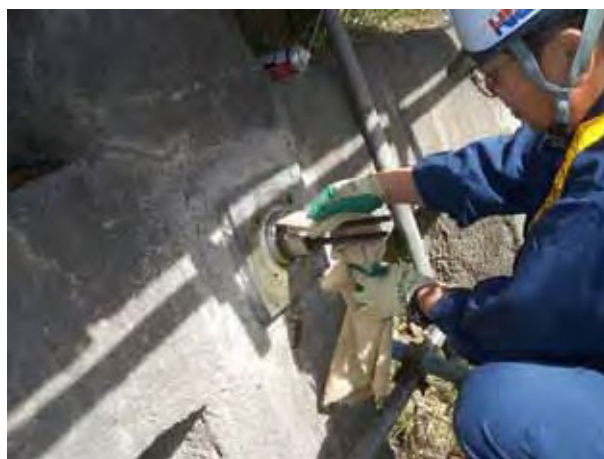
防錆油の除去、アンカーヘッドの確認
