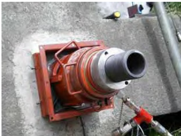
-5 テンションロッド・ナットの取付け
