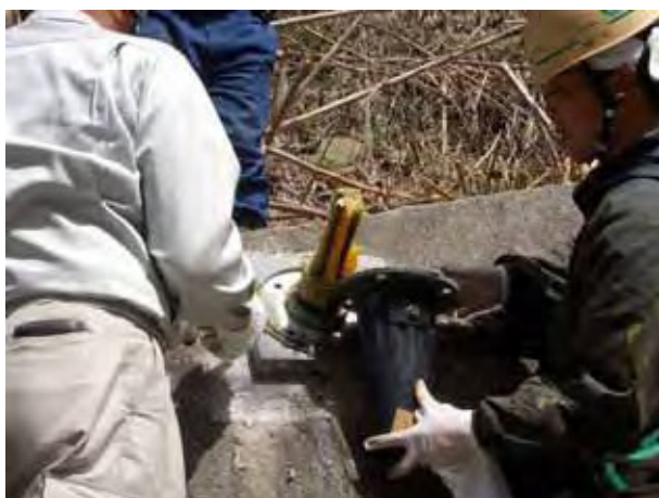
アンカーヘッドキャップの取外し
