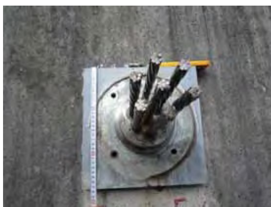
写真 10.4 アンカーヘッド構造 (正面)
