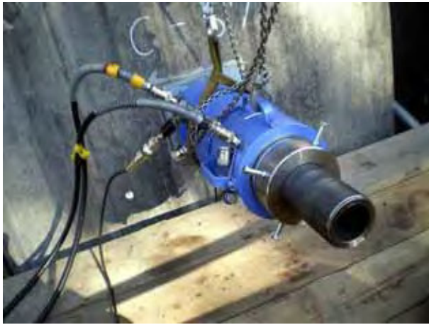
-5 油圧ジャッキ、テンションナットの取付け
