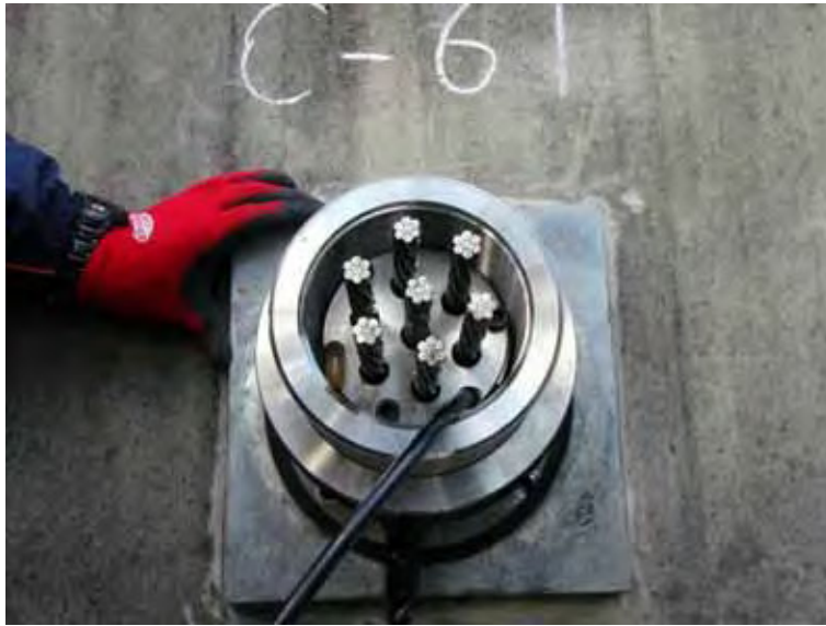
写真 10.95 防錆油充填状況 (荷重計内)
