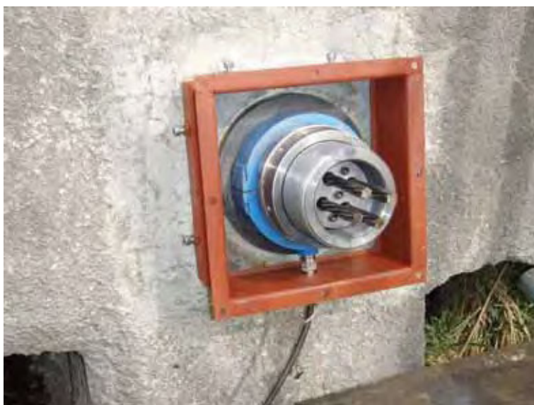
写真 10.18 荷重計取付け状況
