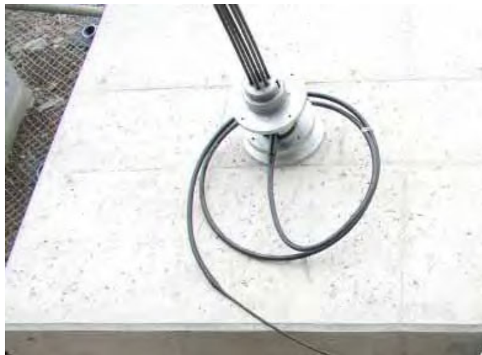
写真 11.13 地すべり対策工事におけるグラウンドアンカーの軸力測定実施状況 (差動トランス式荷重計)
