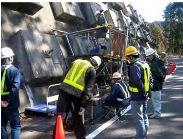
写真 10.94 リフトオフ試験 状況
