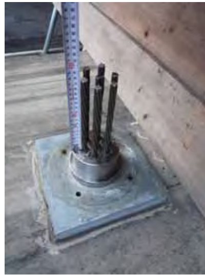
a) 荷重計取付け時 (H21.1)
