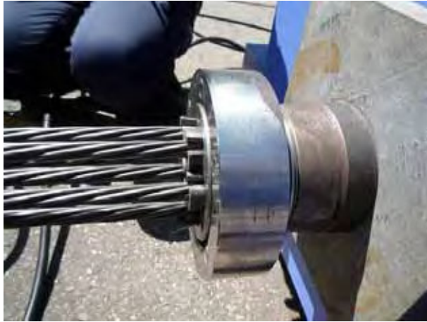
写真 11.31 取外し後のくさび状況
