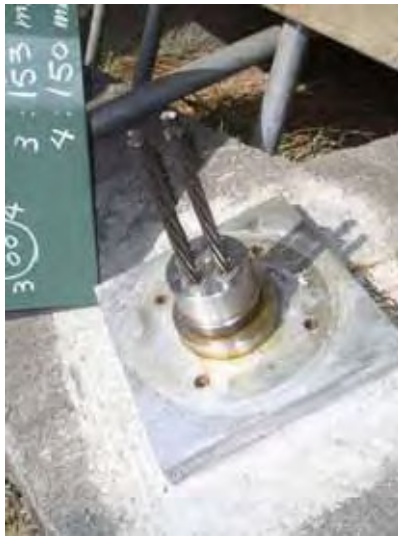
a) 荷重計取付け時 (H20.4)
