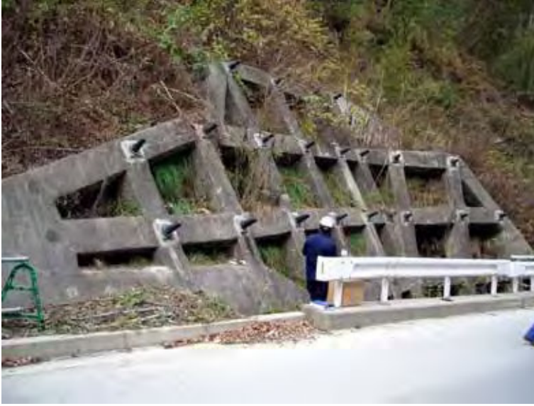
写真 10.21 試験前の法面
