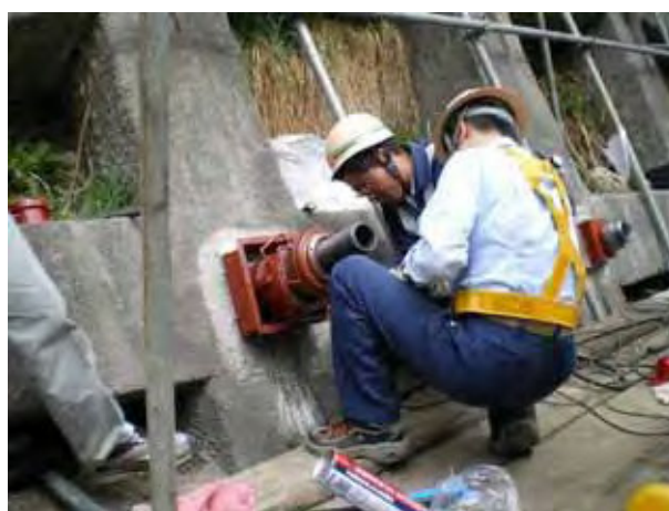
緊張治具の取外し
