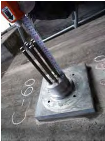
a) 荷重計取付け時 (H21.1)
