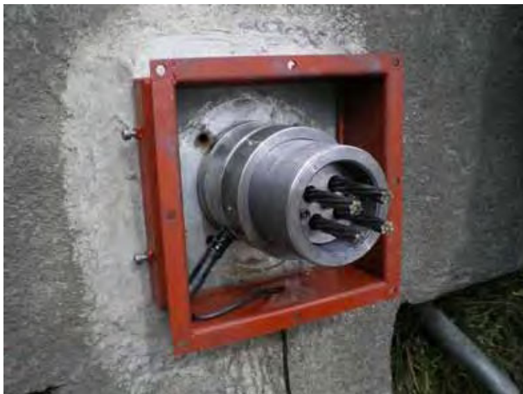
写真 10.16 荷重計取付け状況
