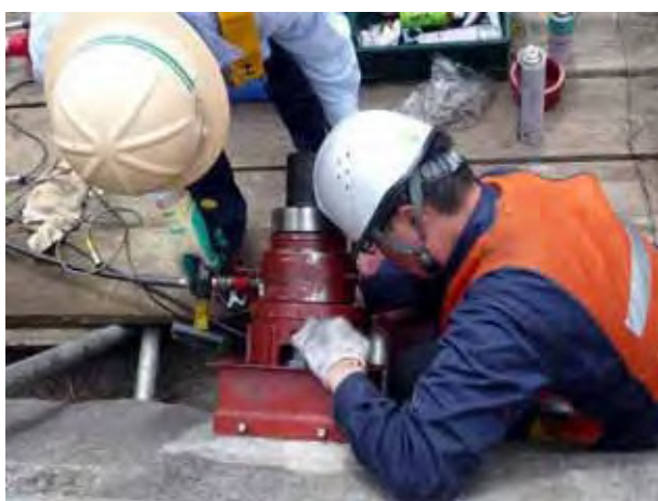
荷重計への緊張力移行
