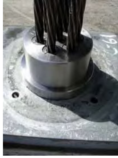
c) 現状復旧 (錆の除去) の状況 (H21.9)
