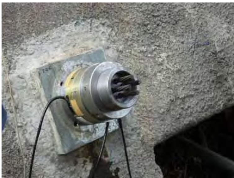
写真 10.14 荷重計取付け状況
