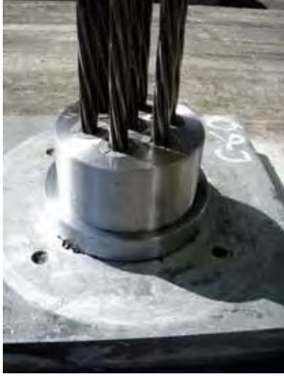
c) 現状復旧 (錆の除去) の状況 (H21.9)
