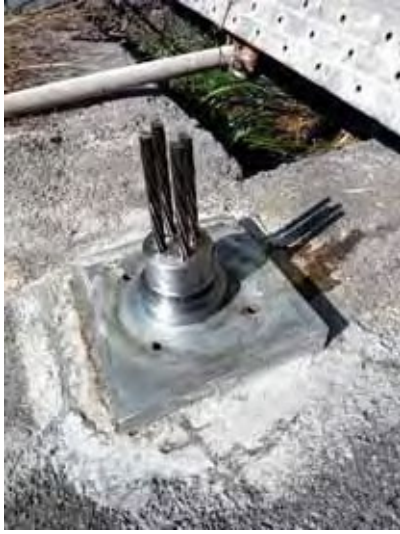
c) 現状復旧 (錆の除去) の状況 (H21.5)
