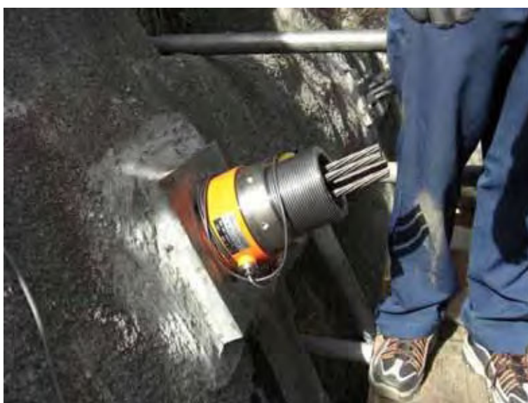
写真 10.15 荷重計取付け状況
