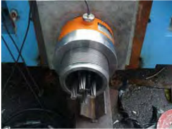
テンションスリーブ、定着ナットの取付け
