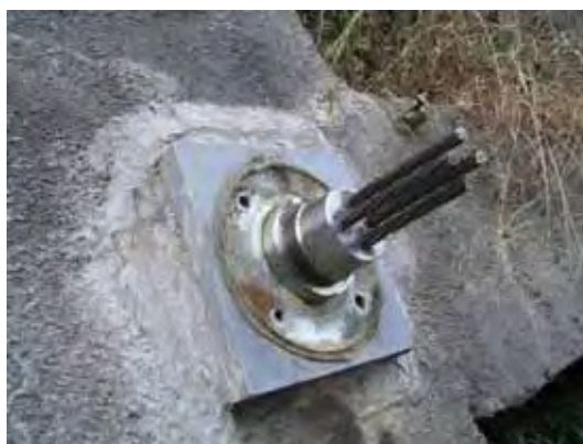
写真 10.1 アンカー頭部構造(斜め)
