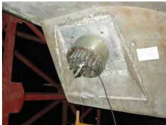
写真 11.10 斜材の張力測定実施状況（ひずみゲージ式荷重計）
