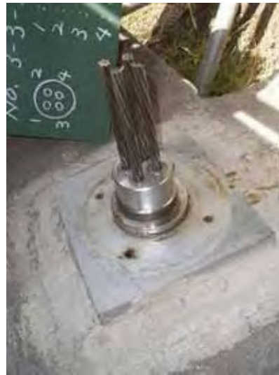
a) 荷重計取付け時 (H20.4)
