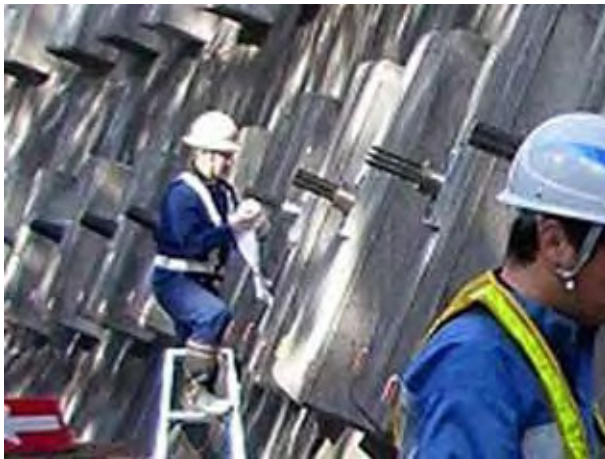
アンカーヘッドキャップの取外し
