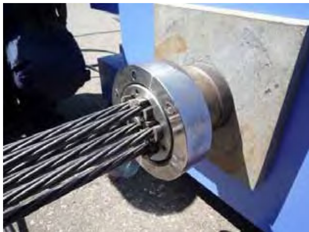
写真 11.30 取外し後のくさび状況
