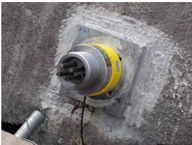
写真 10.13 荷重計取付け状況
