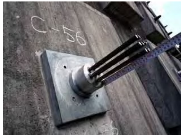
防錆油の除去、アンカーヘッドの確認
