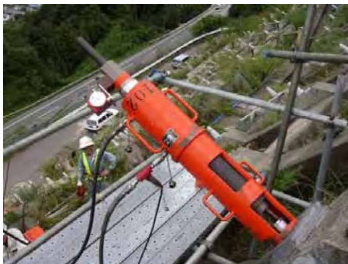
写真 11.7 リフトオフ試験状況
