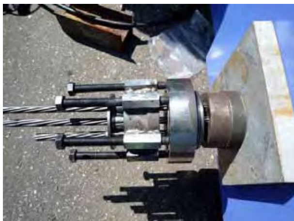
写真 11.27 反力ボルトの締付け
