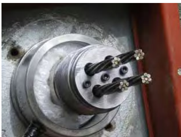
-3 ジョイントスリーブの取付け
