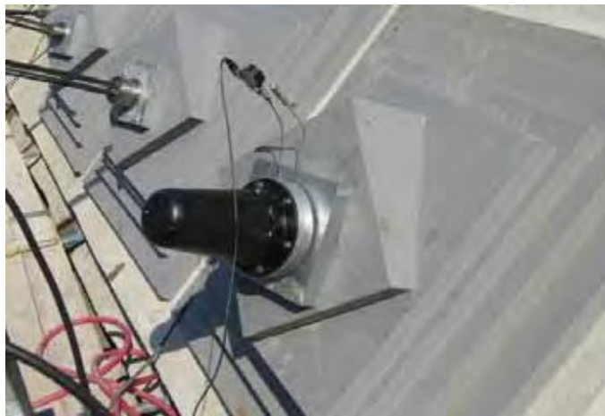
写真 11.15 ダム側面のグラウンドアンカー軸力測定実施状況 2 (油圧式荷重計)
