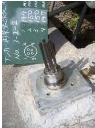
a) 荷重計取付け時 (H20.4)
