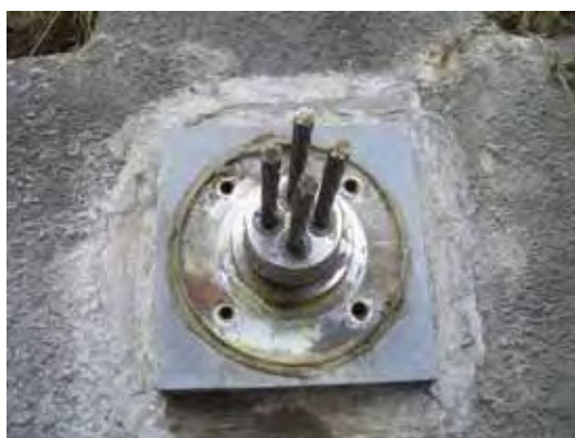
写真 10.2 アンカー頭部構造(正面)
