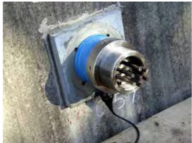
-2 下テンションスリーブ、定着ナットの取付け
