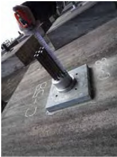
a) 荷重計取付け時 (H21.1)
