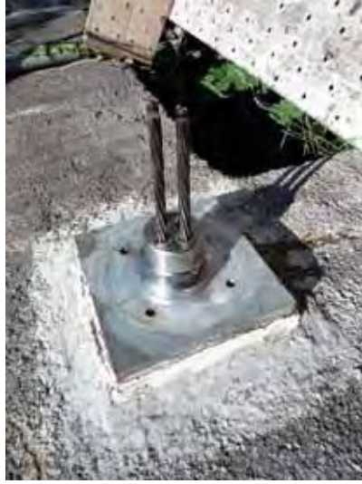
c) 現状復旧 (錆の除去) の状況 (H21.5)
