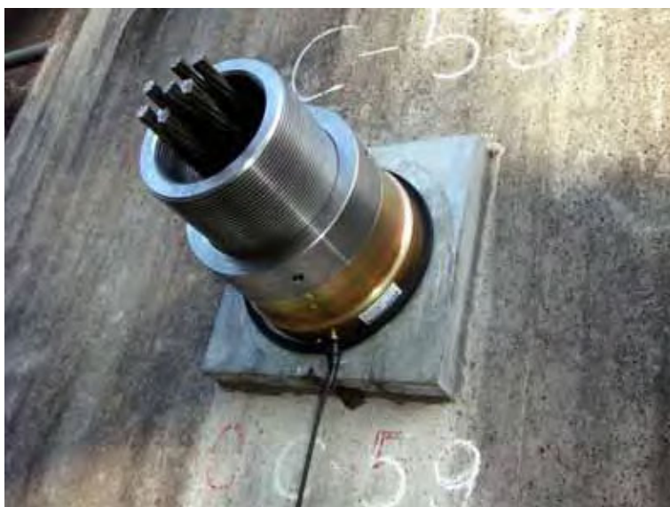
写真 10.63 荷重計取付け状況
