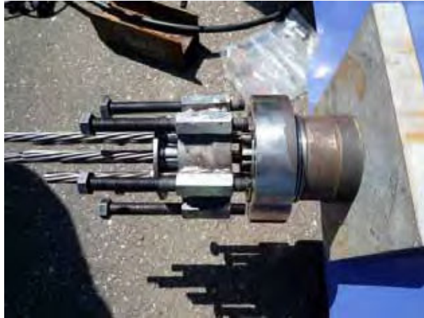
写真 11.28 ジョイントスリーブ取外し完了
