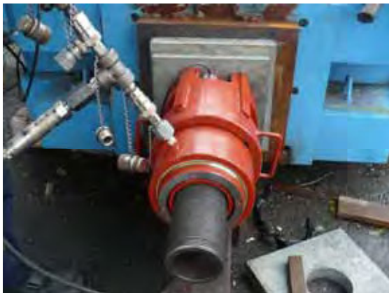
ラムチェア、油圧ジャッキの取付け
