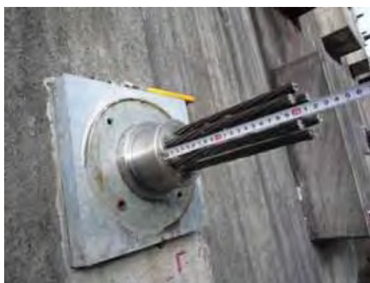
写真 10.3 アンカーヘッド構造 (斜め)
