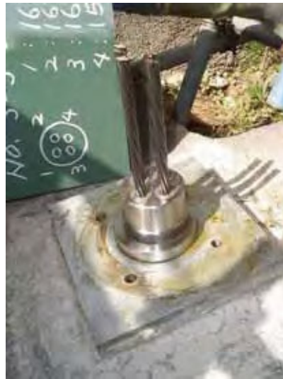
a) 荷重計取付け時 (H20.4)
