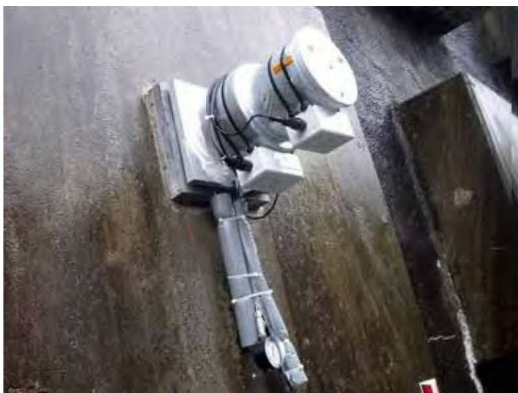
写真 10.62 荷重計取付け状況
