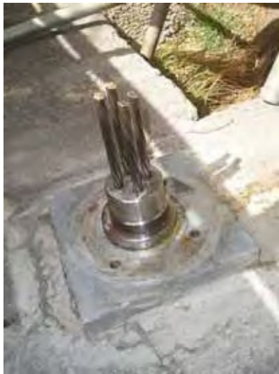
a) 荷重計取付け時 (H20.4)
