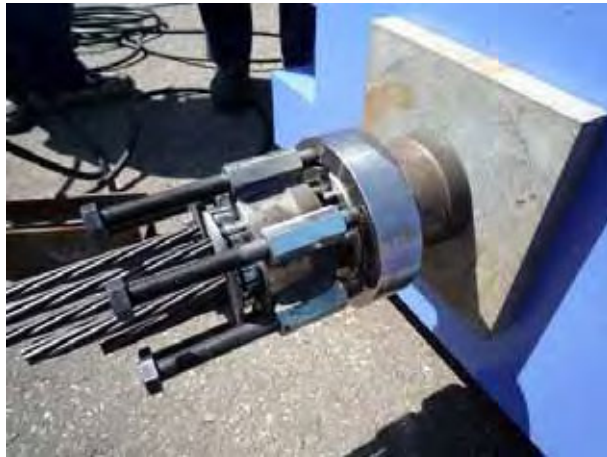
写真 11.29 ジョイントスリーブ取外し完了
