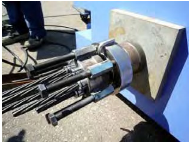
写真 11.26 反カスリーブの取付け
