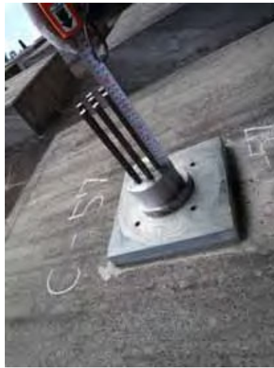
a) 荷重計取付け時 (H21.1)
