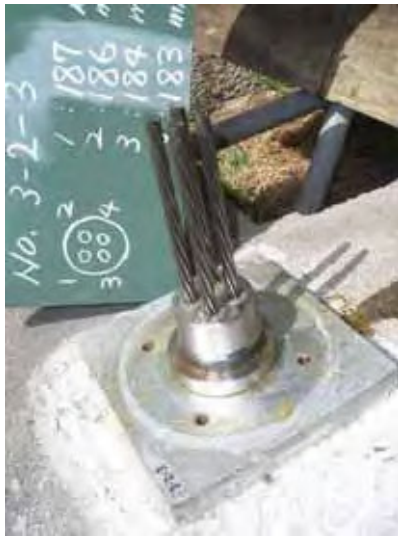
a) 荷重計取付け時 (H20.4)
