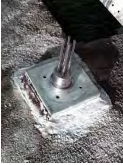
c) 現状復旧 (錆の除去) の状況 (H21.5)
