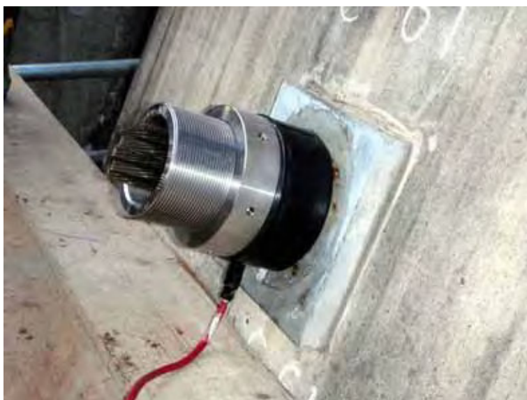
写真 10.65 荷重計取付け状況
