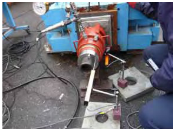
テンションナット取付け (リフトオフ開始)
