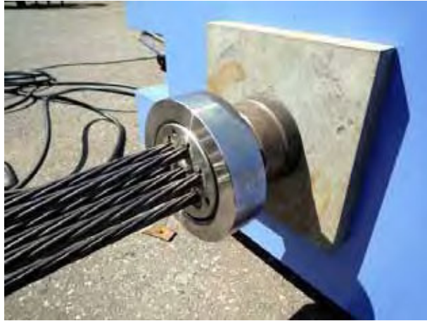
写真 11.25 取外しナットの取付け
