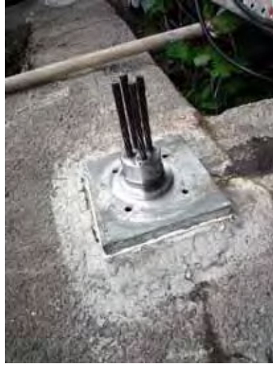
c) 現状復旧 (錆の除去) の状況 (H21.5)
