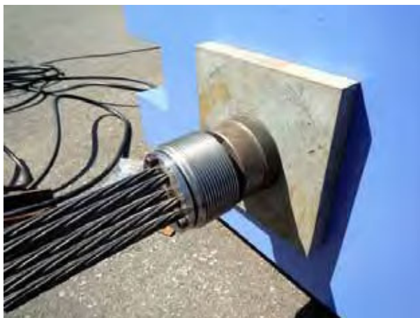
写真 11.23 ジョイントスリーブの取付け状況
