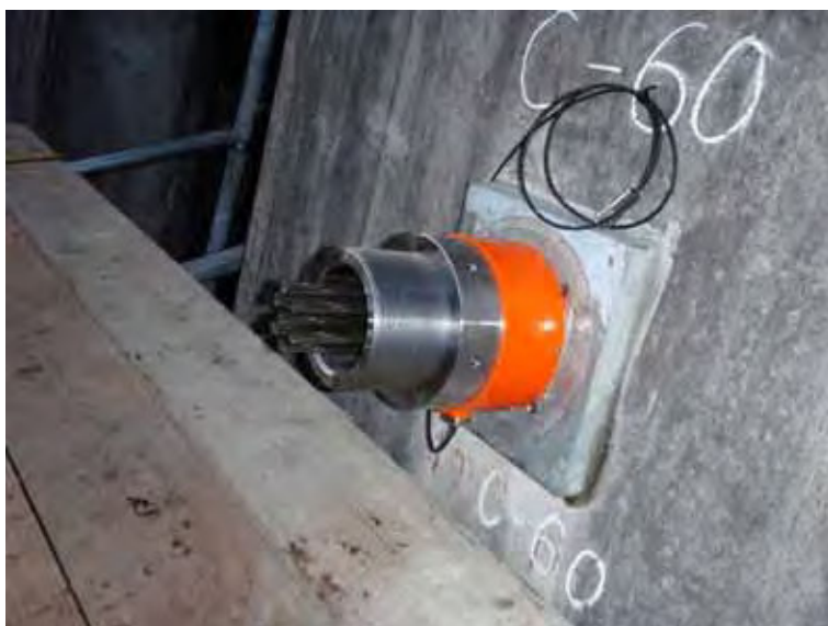
写真 10.64 荷重計取付け状況
