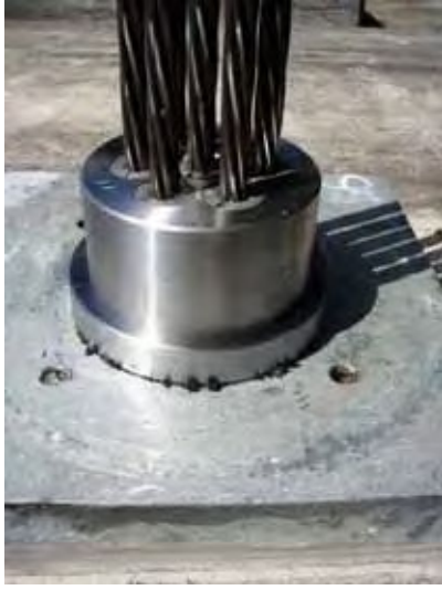
c) 現状復旧 (錆の除去) の状況 (H21.9)
