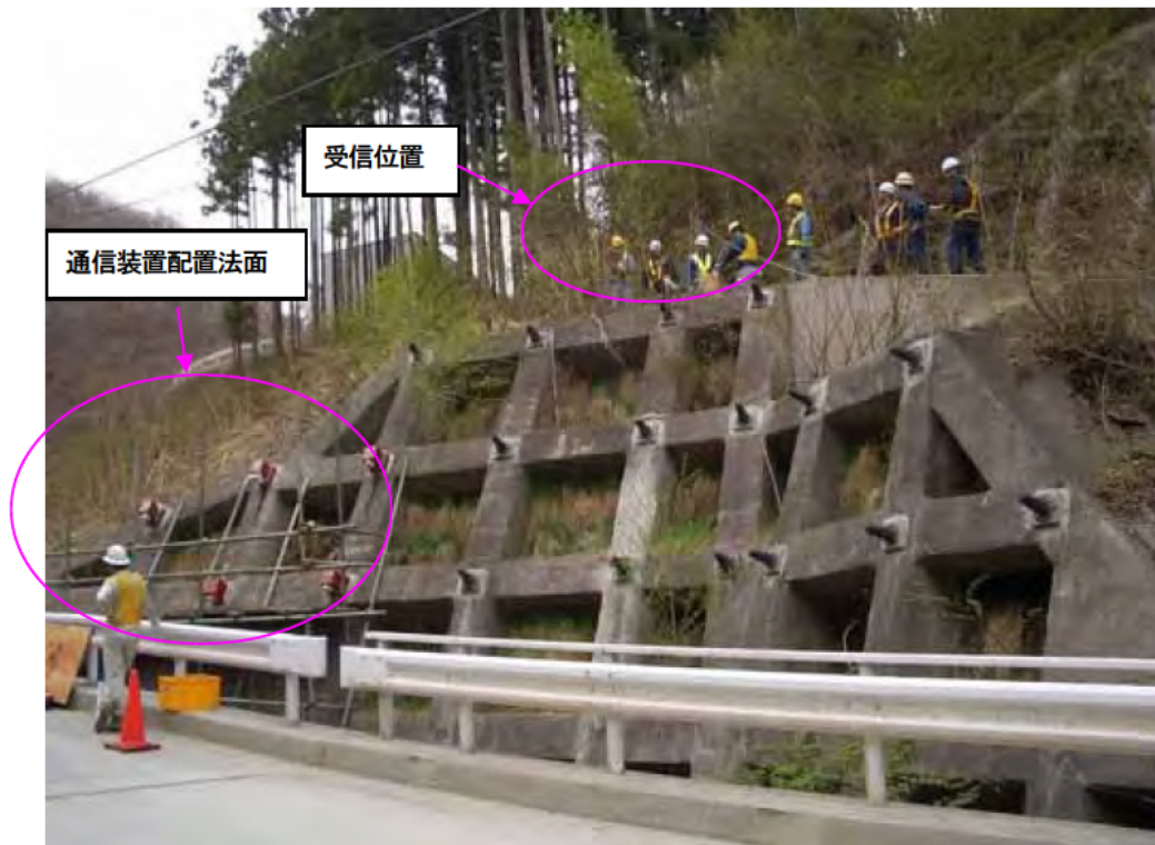
写真 10.99 アンカー直上通信試験状況
