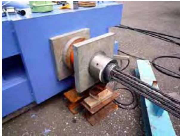
写真 11.34 模擬緊張用ジャッキ側のアンカーヘッドによる定着
