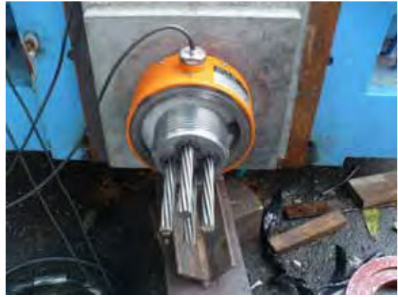
荷重計の取付け
