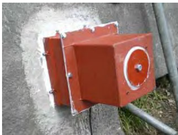
-2 上部ヘッドキャップ取付け
