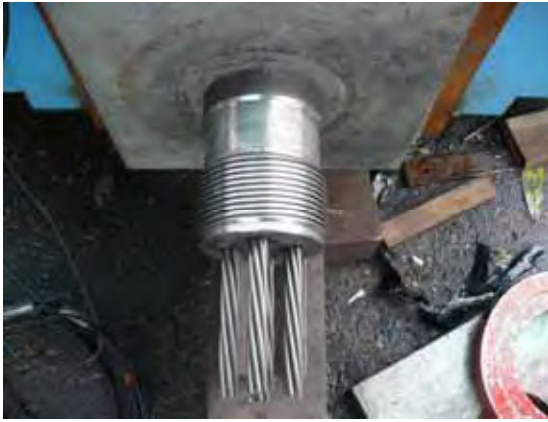
ジョイントスリーブの取付け
