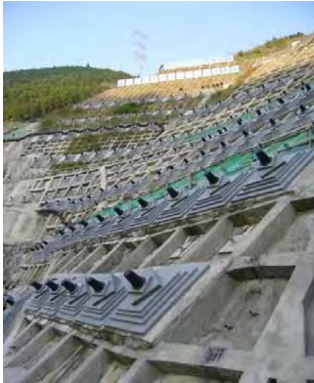
写真 11.14 ダム側面のグラウンドアンカー軸力測定実施状況 1 (油圧式荷重計)
