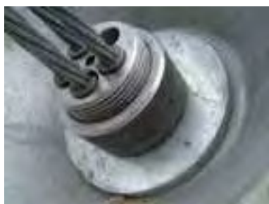
くさび・ナット併用方
