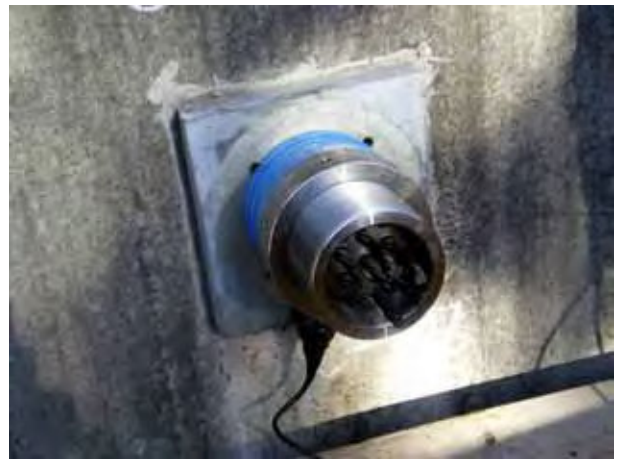
荷重計定着完了
