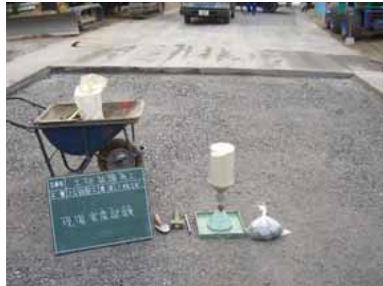
写真-5.5 現場密度試験(上層路盤)
