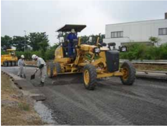
写真-5.2 敷きならし状況(上層路盤)
