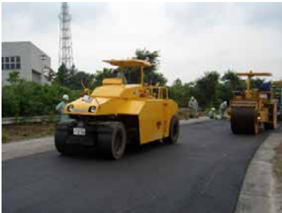
写真-5.8 2次転圧状況
