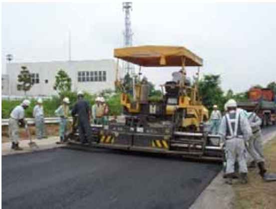
写真-5.6 敷きならし状況
