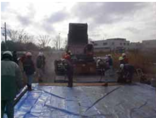
写真-5.9 敷きならし状況
