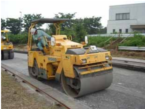
写真-5.4 転圧状況(上層路盤)
