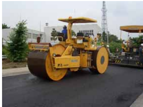
写真 - 5.7 初期転圧状況
