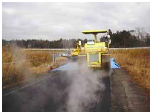
写真-5.10 初期転圧状況
