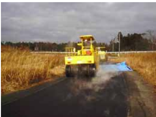
写真-5.11 2次転圧状況
