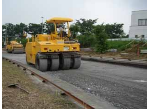
写真-5.3 転圧状況(上層路盤)
