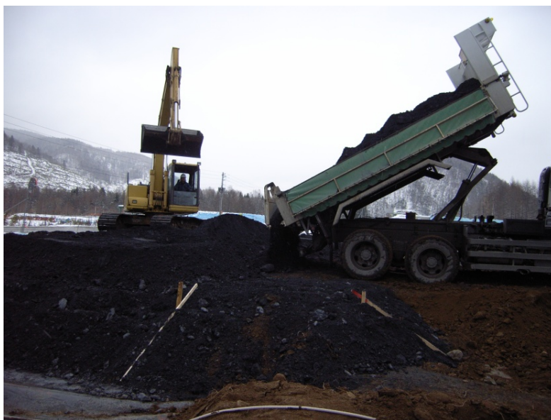
写真-2 試験盛土の施工状況
