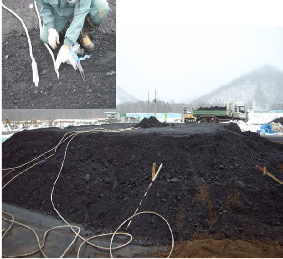
写真-1 計測器の設置状況
