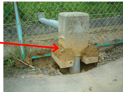
写真2-3 宮城県北部地震時の被災状況ポリエチレン管
