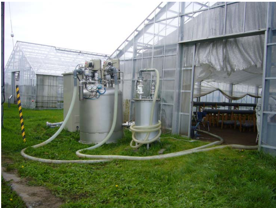
写真4-1-2 小型真空ステーション（CP200）の設置状況
