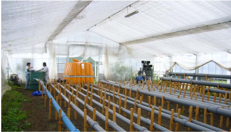
写真4-1-1 試験管路（実証プラント）の設置状況
