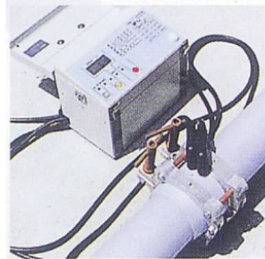
[ポリエチレン管EF接続状況]
