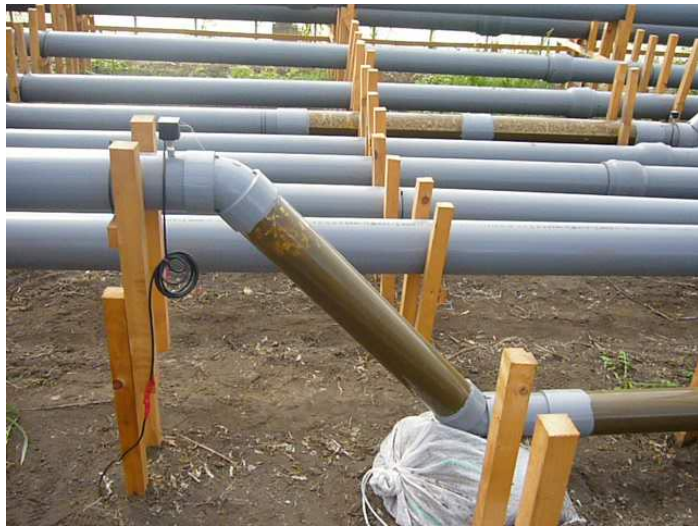
写真4-1-6 リフトでのふん尿の流送状況
