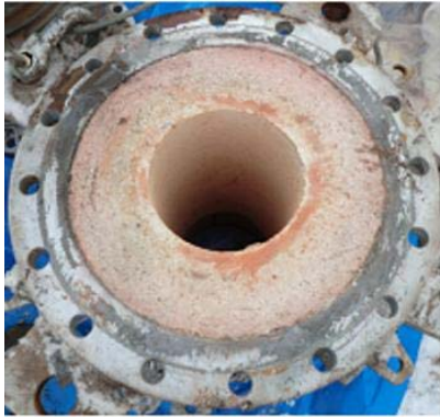
図-3.7.11 集塵機入口排ガスダクト
