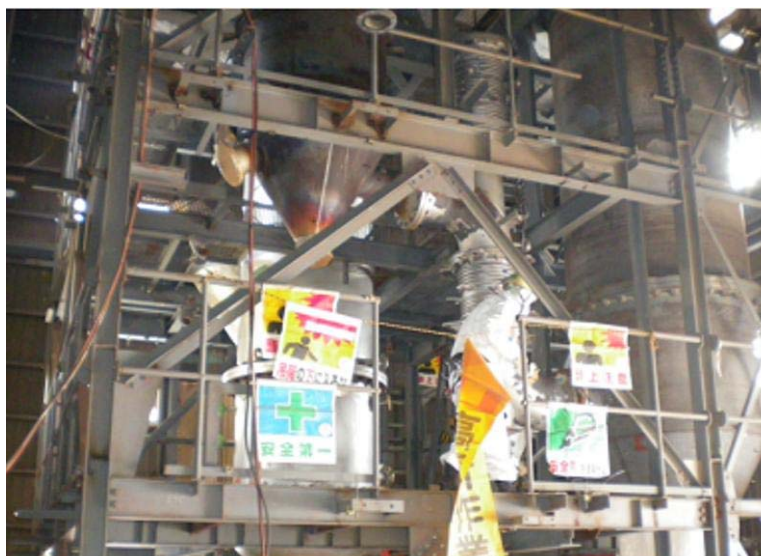
図-3.7.1 解体工事（研究） 風景
