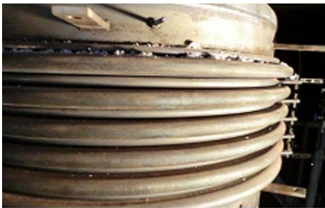
図-3.7.7 空気予熱器コンペンセータならびに下部ヘッド (右)
