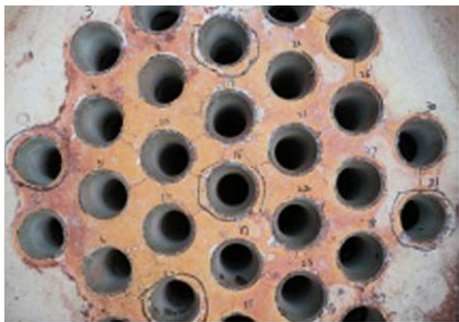
図-3.7.6 空気予熱器 管板・チューブならびにチューブ内 (右)
