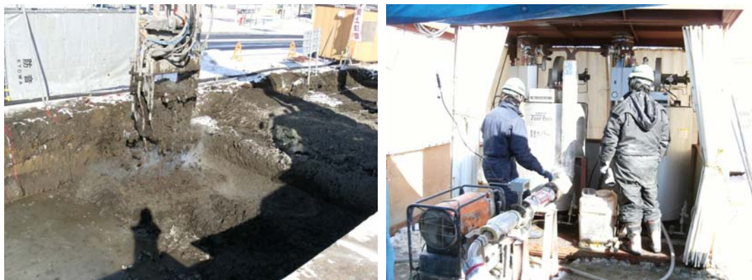
写真-4.4 ヒートソイル工法の施工状況、ボイラーの運転状況
