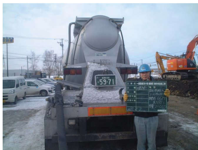
写真-2.3 改良材搬入状況 (特殊土用固化材)
