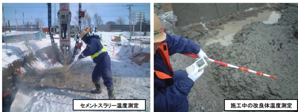
写真-3.6 温度測定状況
