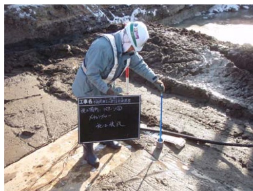
写真-4.7 メチレンブルー設置状況
