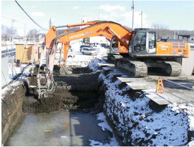
写真-2.4 施工状況①
