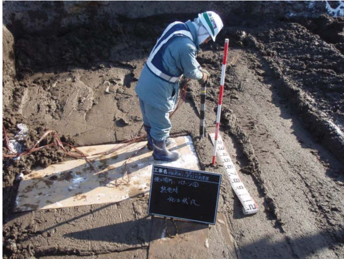
写真-2.10 熱電対設置状況
