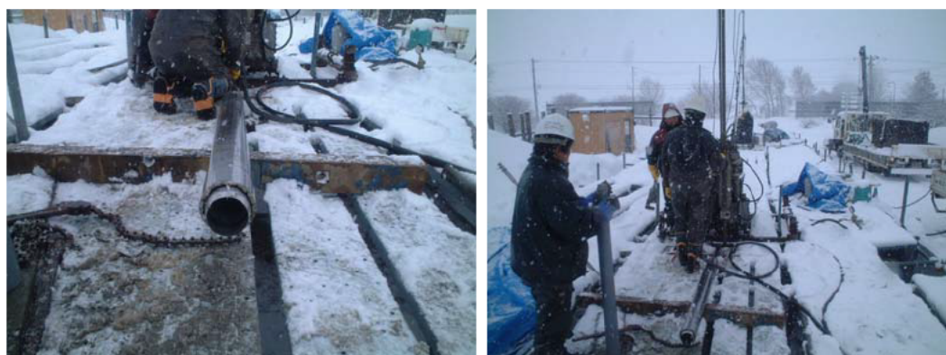
写真-3.8 トリプルチューブサンプリングの作業状況
