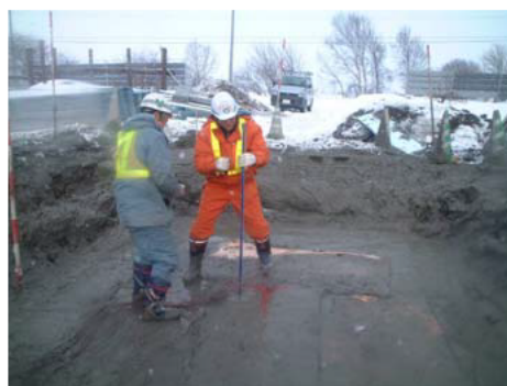
写真-3.7 メチレンブルー設置状況
