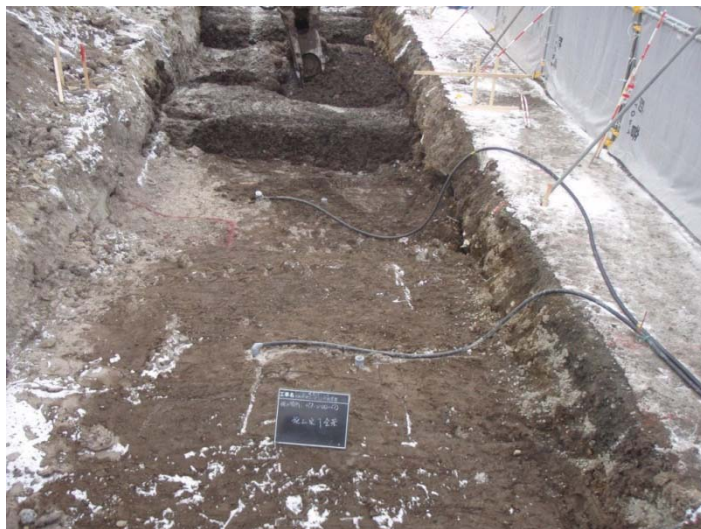
写真-2.12 熱電対・メチレンブルー設置完了（パターン①、②）
