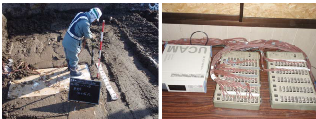
写真-4.6 熱電対設置状況、データロガー
