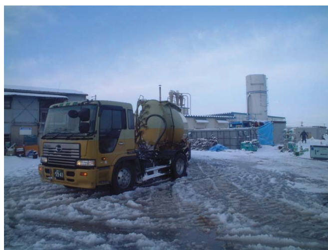
写真-1.3 改良材搬入状況 (特殊土用固化材)
