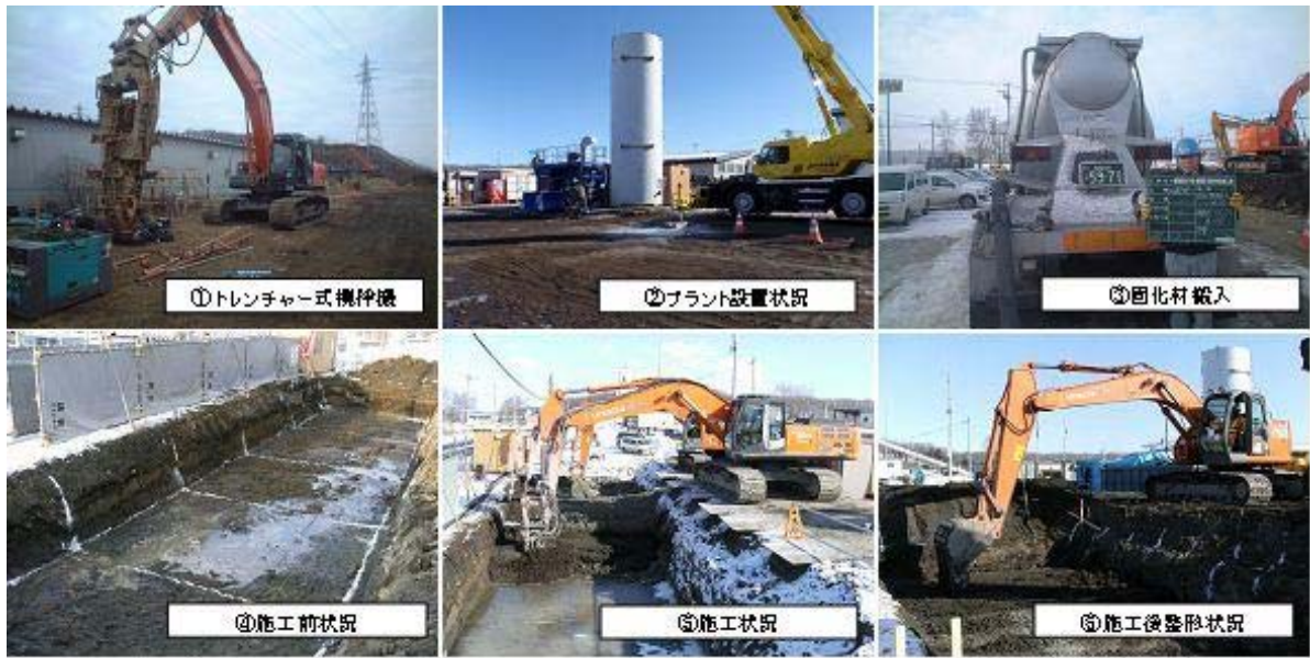
写真-4.1 施工状況
