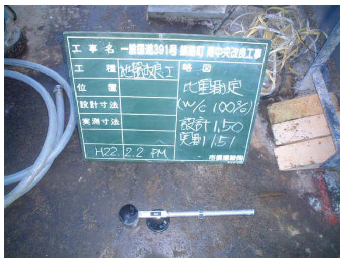
写真-2.7 セメントスラリー比重測定
