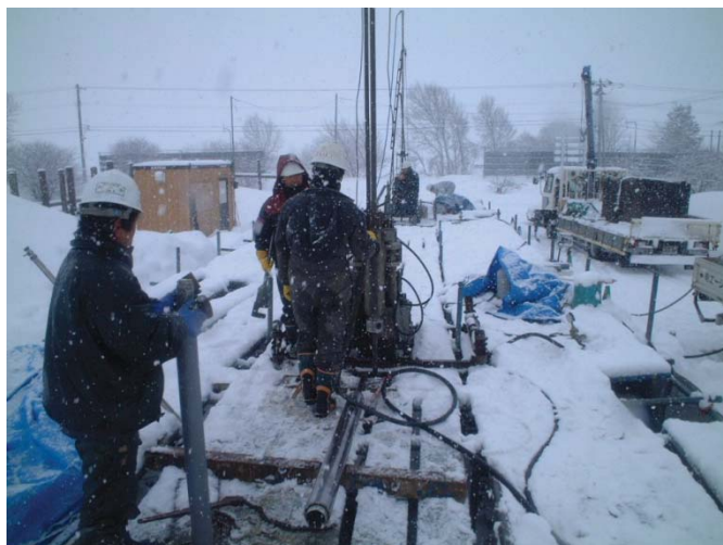
写真-1.1 コアサンプリング採取状況
