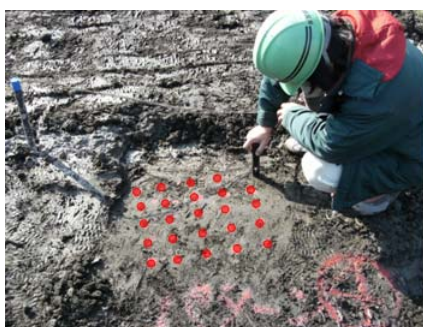
写真-5.6 現場の早期強度測定
