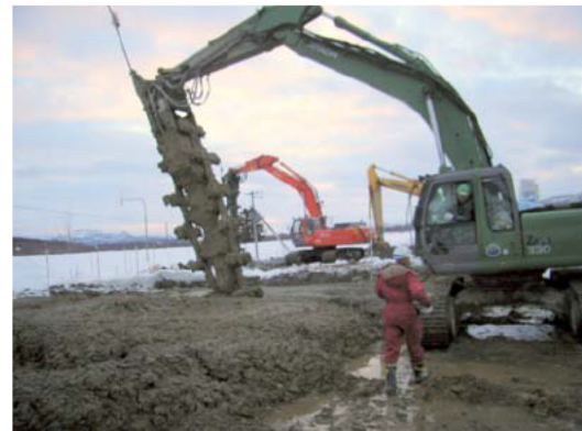
写真-2.1 厳冬期の作業状況
