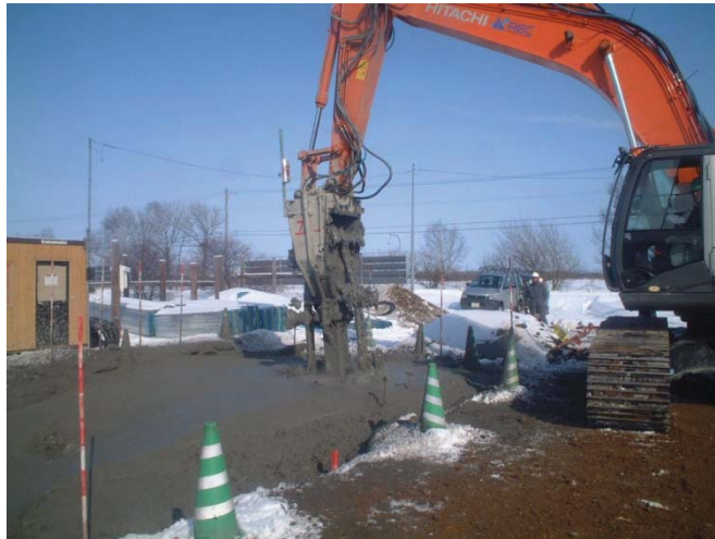
写真-1.5 施工状況②
