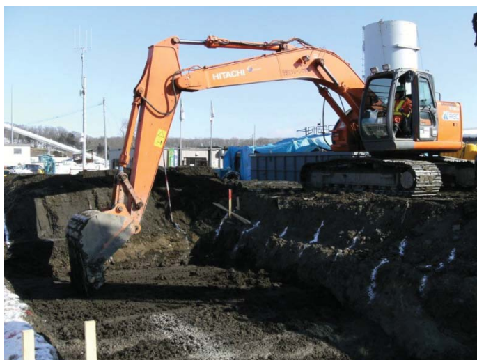
写真-2.8 基面整正完了
