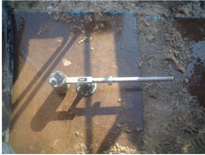
写真-1.7 セメントスラリー比重測定
