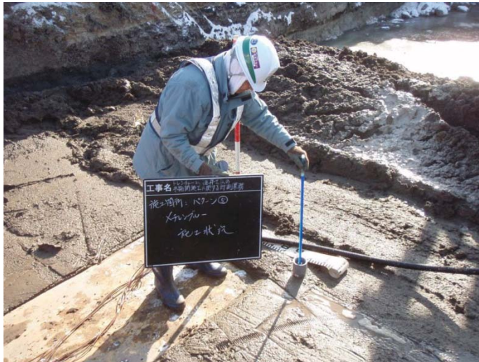
写真-2.11 メチレンブルー設置状況
