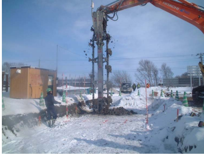
写真-1.4 施工状況①
