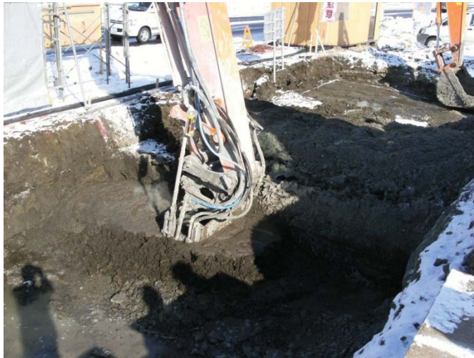
写真-2.5 施工状況②
