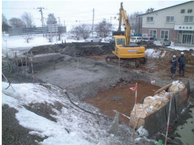
写真-1.8 基面整正完了
