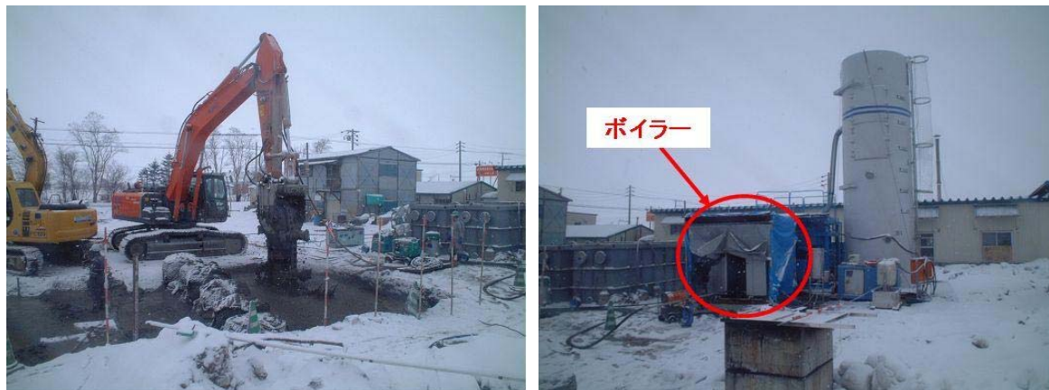
写真-3.4 ヒートソイル工法の施工状況
