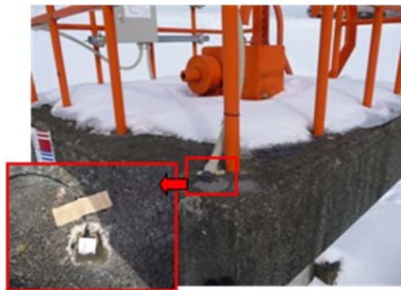
写真-3.1.2 温湿度センサーの設置状況
