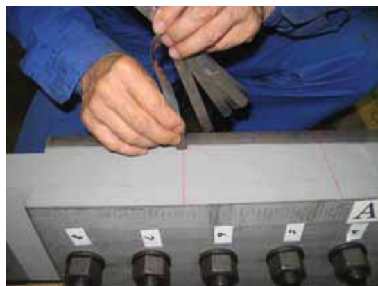
写真-3.2.2 肌すき量の計測状況
