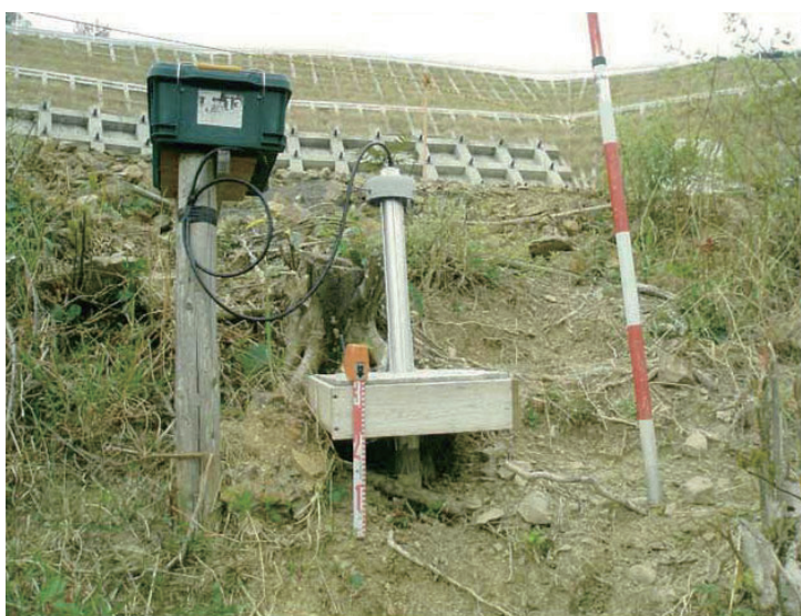
写真-3-1-1-2 孔内傾斜計ガイド管の浮き上がり例
