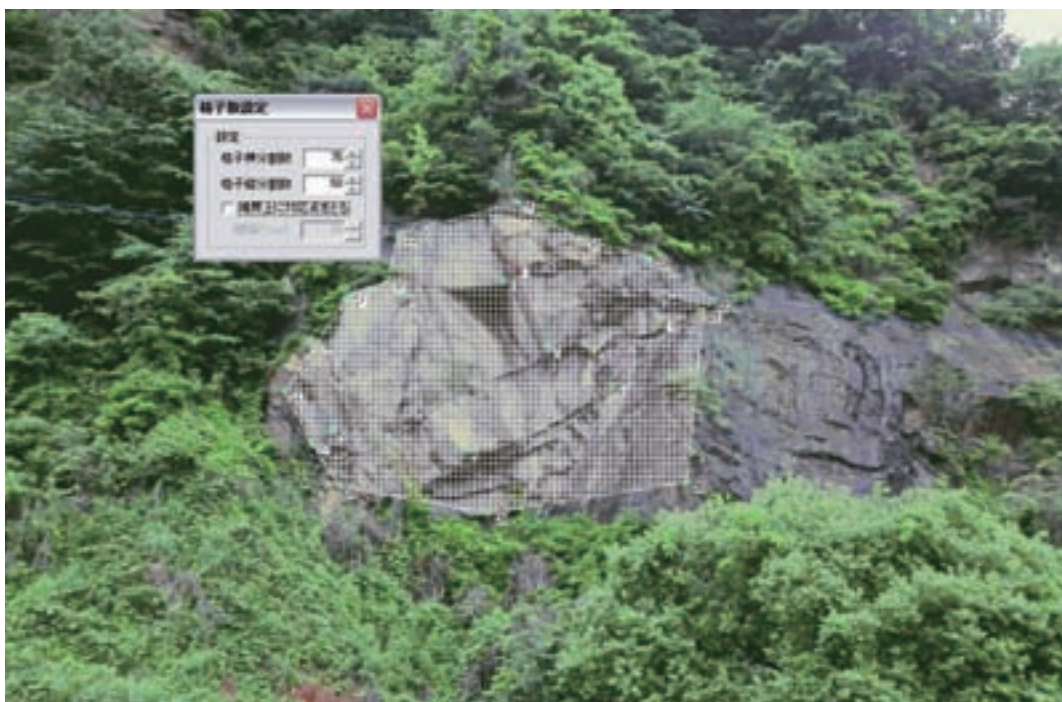
図 3.79 R写真上に設定したメッシュ (75列×50行、境界上に点を配置しない)
