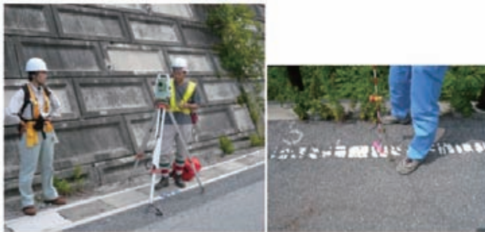
写真 3.2 観測状況写真
