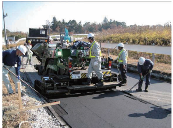
写真-3.8 中間層敷きならし状況
