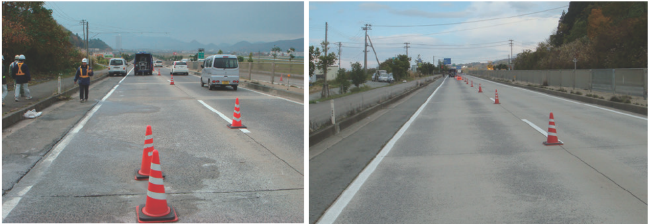
写真-3.71 国道 113 号の現場状況 (左：上り線、右：下り線)
