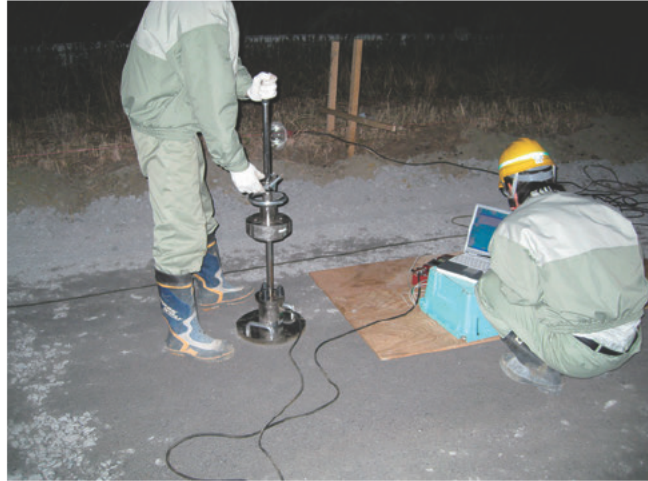
図-5.4 小型 FWD 試験による支持力調査状況
