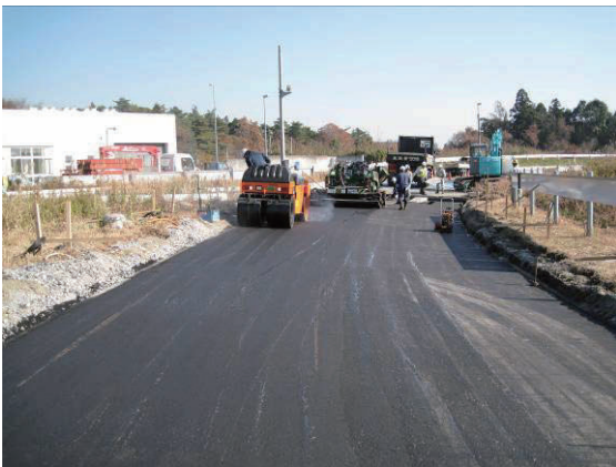
写真-3.9 中間層転圧状況
