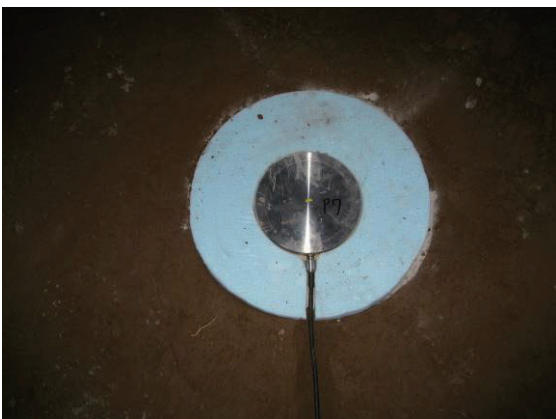
写真-3.22 土圧計埋設状況（路床）
