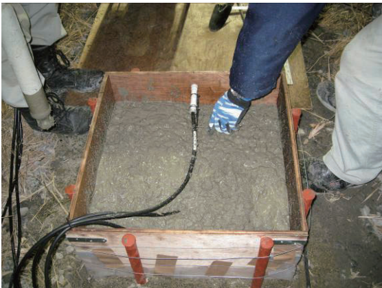
写真-3.20 ダミー版打設
