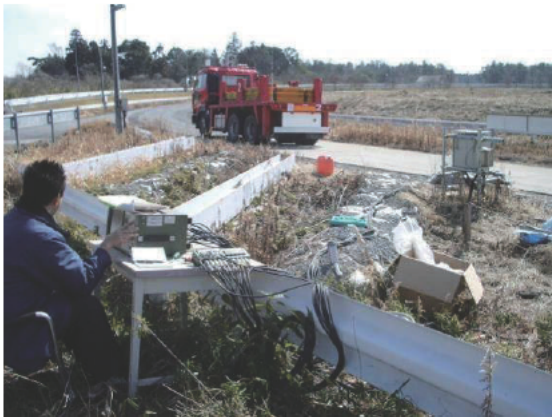
写真-3.56 動的載荷試験の計測状況 (中間層有工区)
