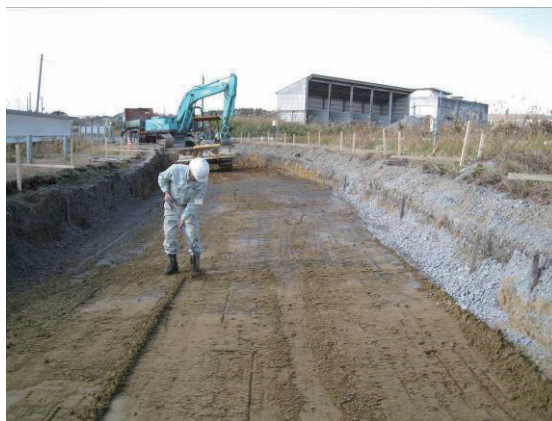
写真-3.2 仕上がり状況
