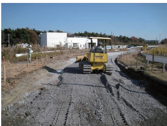
写真-3.5 路盤敷ならし状況
