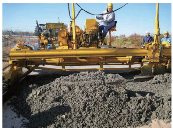
写真-3.11 コンクリート敷ならし状況
