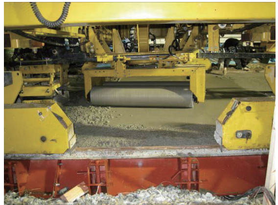
写真-3.15 シリンダフィニッシャーによる仕上げ
