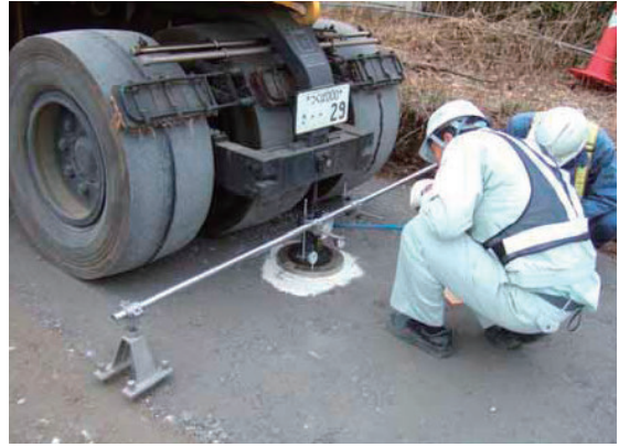
写真-3.79 路盤上面での平板载荷試験
