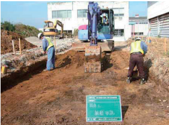
写真-3.72 現地盤の掘削状況
