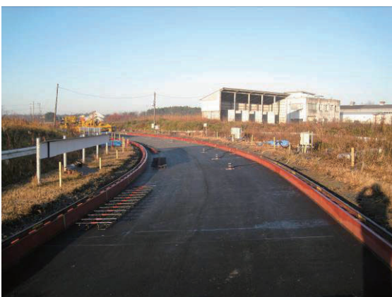
写真-3.10 打設前状況
