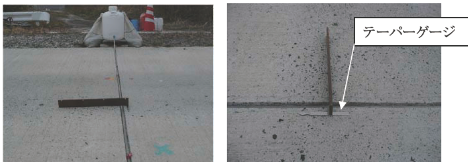
写真-3.37 段差測定状況 (テーパーゲージ使用)
