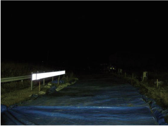
写真-3.18 養生状況
