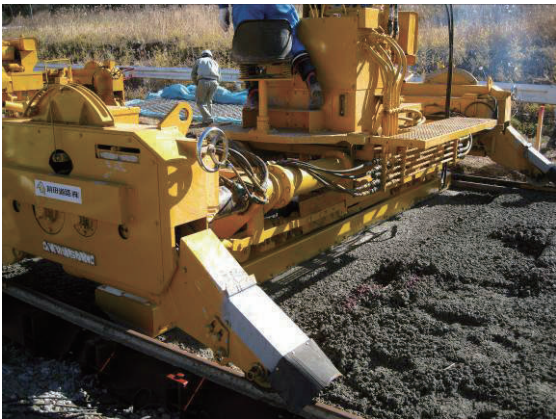
写真-3.14 締め固め状況
