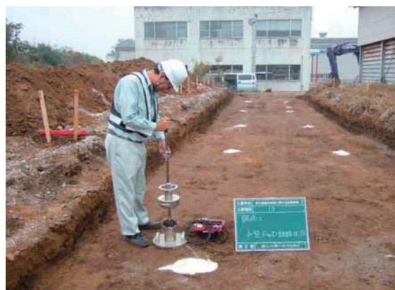
写真-3.75 路床上面での小型 FWD 試験
