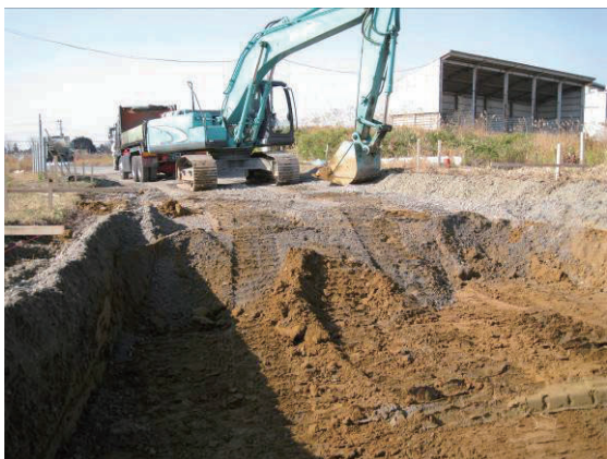
写真-3.1 現地盤掘削状況
