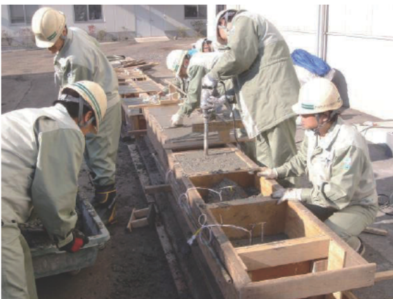
写真-3.62 コンクリートの打設状況
