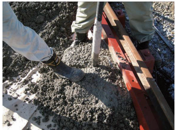
写真-3.27 ひずみ計付近の締固め状況
