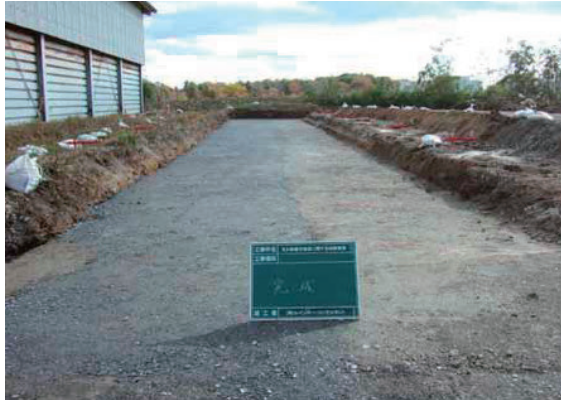
写真-3.81 構築した路盤
