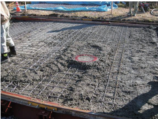
写真-3.28 ひずみ計埋設状況
