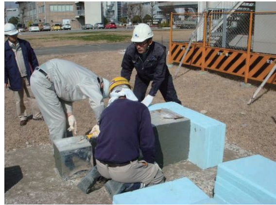
写真-3.66 断熱材設置状況
