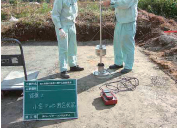
写真-3.80 路盤上面での小型 FWD 試験
