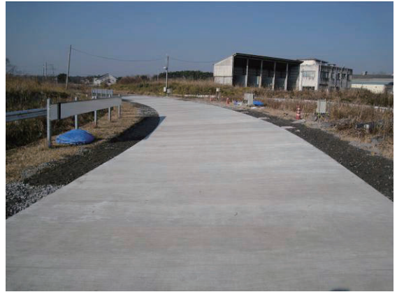
写真-3.19 施工終了時
