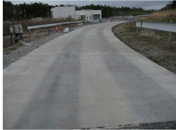
写真-3.33 全体路面状況 (90万輪走行後)
