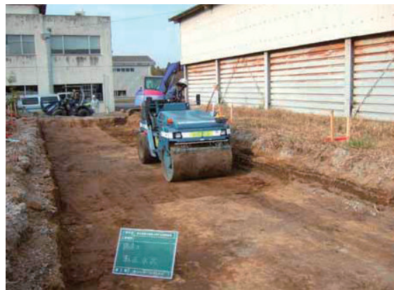
写真-3.73 路床転圧
