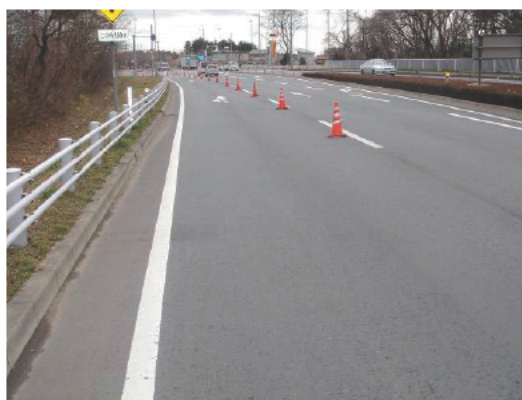
写真-3.69 黒磯バイパスの現場状況
