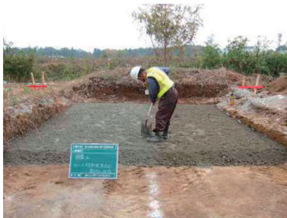
写真-3.77 セメント安定処理層の施工
