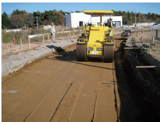
写真-3.4 路床転圧状況
