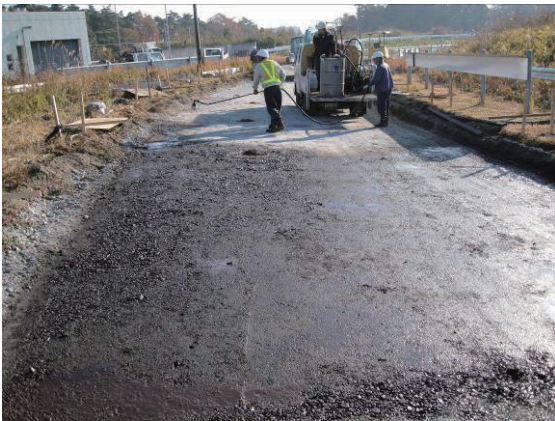
写真-3.7 乳剤散布状況
