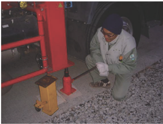
写真-3.51 支持部材の設置状況
