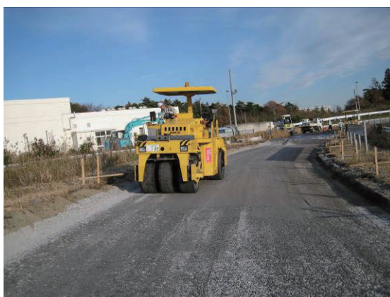
写真-3.6 路盤転圧状況
