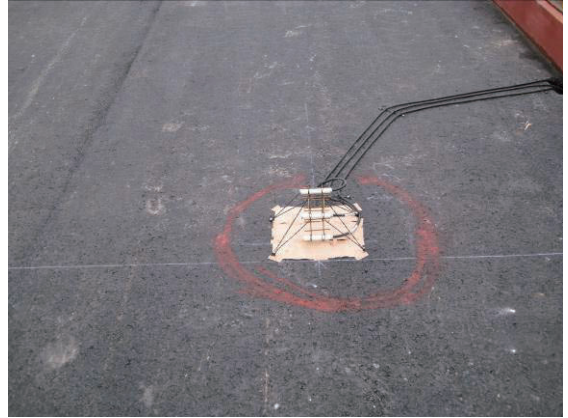
写真-3.25 ひずみ計 (ひび割れ部、目地部)
