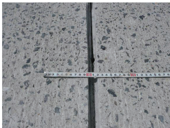
写真-3.41 加工した溝の形状
