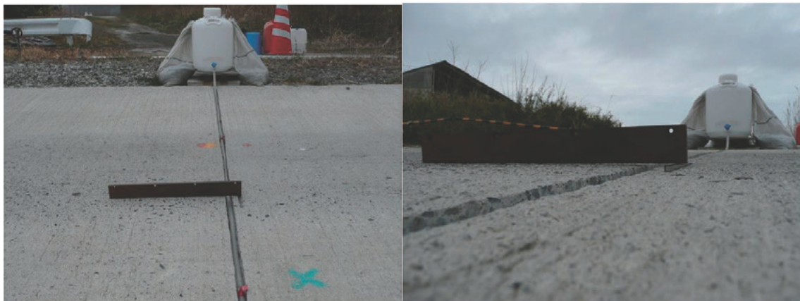
写真-6.1 テーパーゲージによる段差量測定状況 (白タンクとパイプは散水装置)
