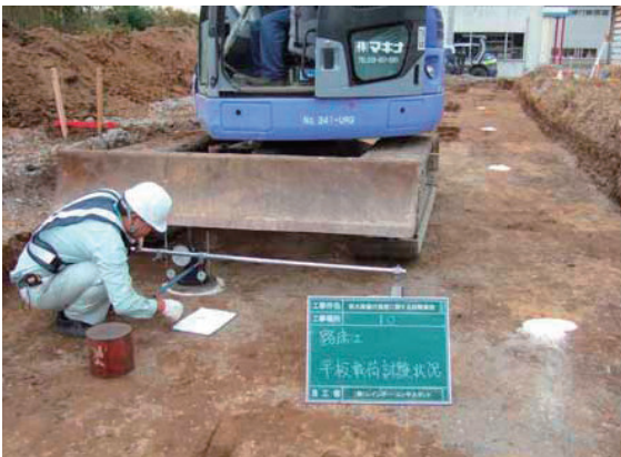
写真-3.74 路床上面での平板荷重試験
