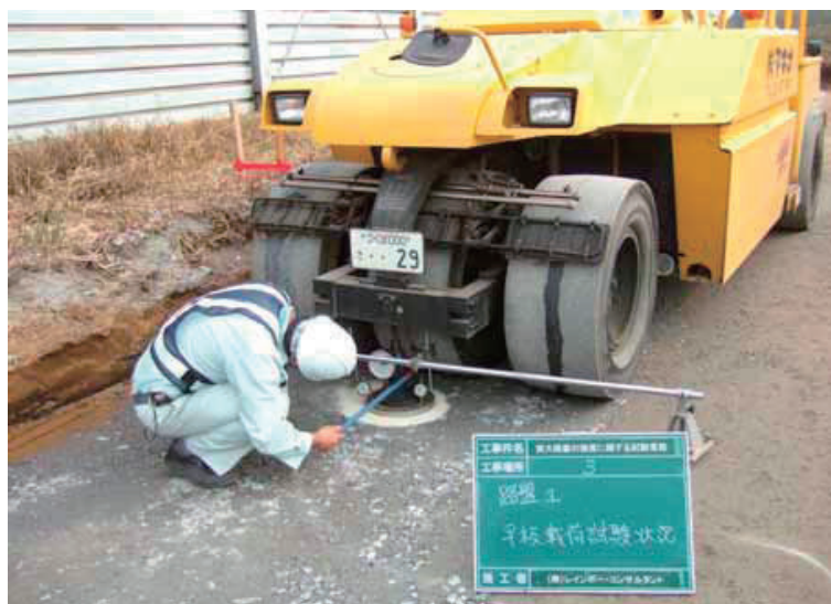
図-5.6 平板載荷試験による支持力調査状況
