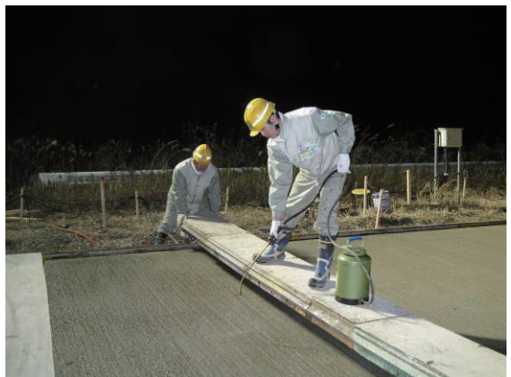
写真-3.17 養生剤散布状況
