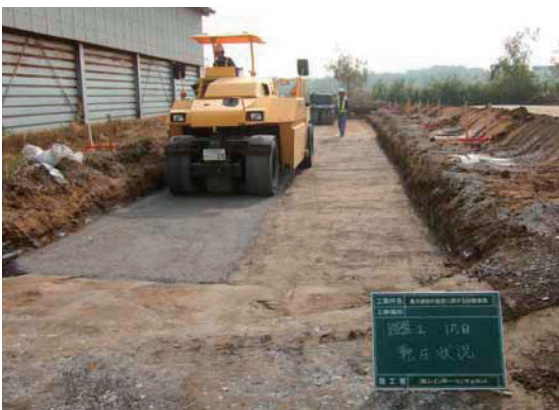
写真-3.76 下層路盤の転圧状況
