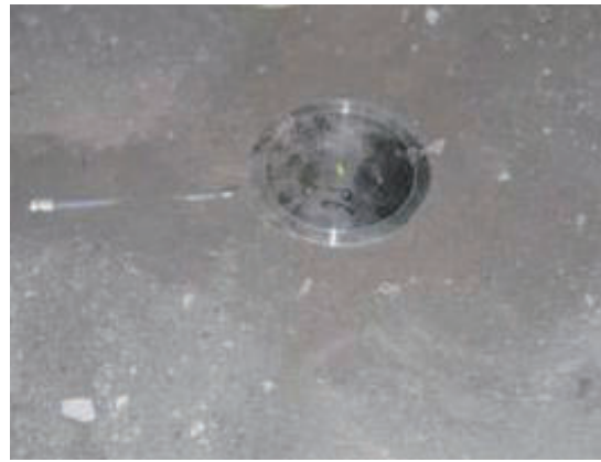
写真-3.23 土圧計埋設状況（路盤）
