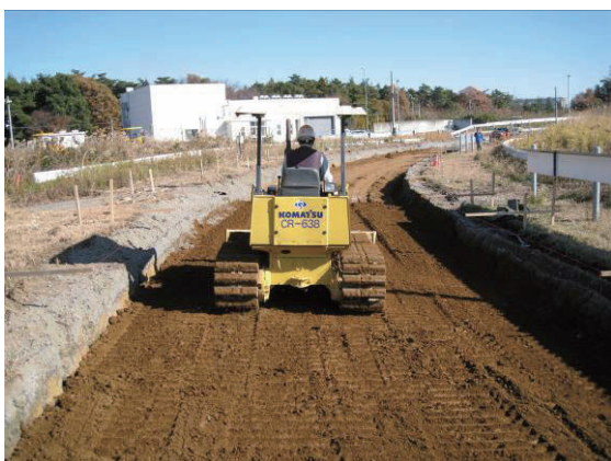
写真-3.3 路床敷ならし状況
