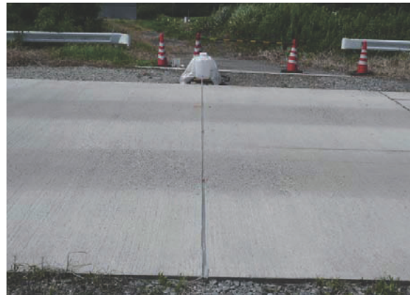
写真-3.43 散水装置
