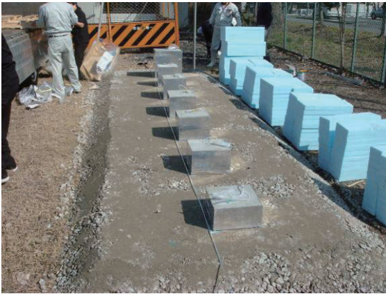
写真-3.65 コンクリート版供試体設置
