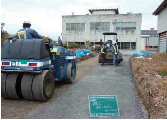
写真-3.78 上層路盤の転圧状況
