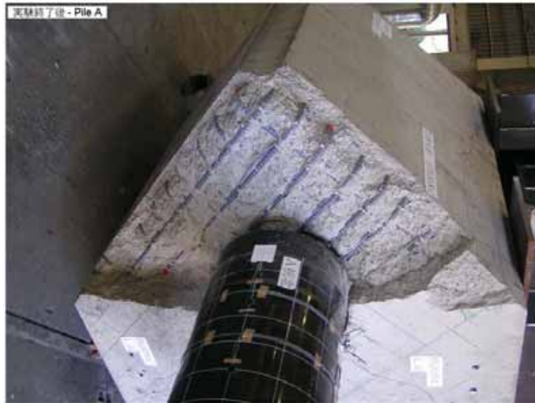
写真-4.19 実験終了後 縁端部損傷状況 (Case SPP-C-2, PileA)
