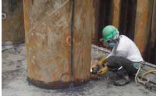
c) 外殻鋼管切断 (カッター)
