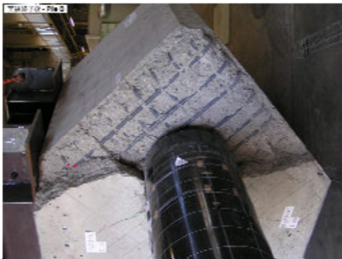
縁端部の損傷状況
