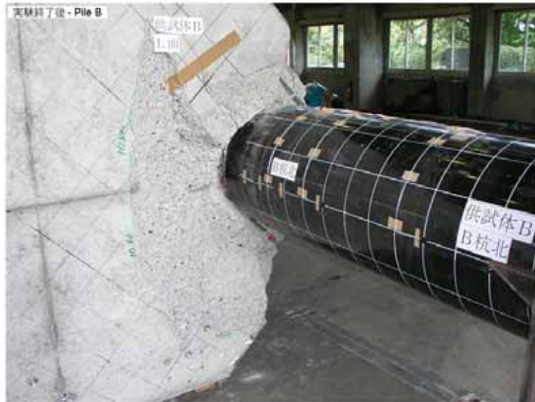
写真-4.17 実験終了後 フーチング下面損傷状況 (Case SPP-C-1, Pile B)
