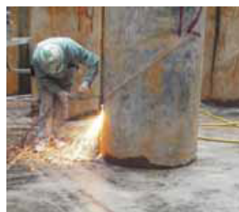
b) 外殻鋼管切断 (ガス溶断)
