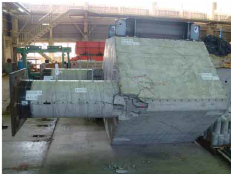
写真-4.9 実験終了後 縁端部損傷状況 (Case CPP-C-2, Pile B)
