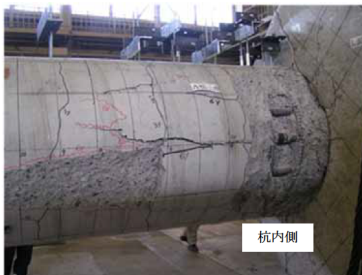
写真-4.4 実験終了後 杭体損傷状況 (Case CPP-C-1, Pile A)
