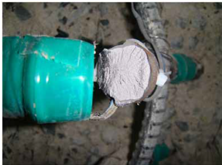
写真-4.13 杭の軸方向鉄筋破断面 (Case CPP-C-2, SD490)
