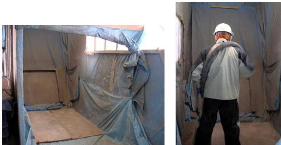
写真-3.1 吹付け状況
