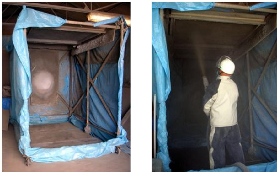
写真-3.3 上向き吹付け状況
