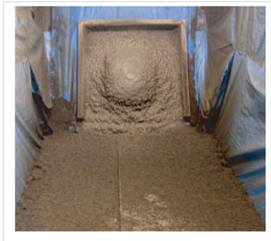
写真-2.5 斜め吹付け時の付着状況の一例 (C360-SF0-V0)
