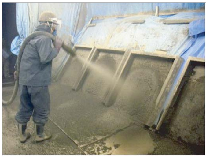
写真-2.2 斜め吹付けの状況
