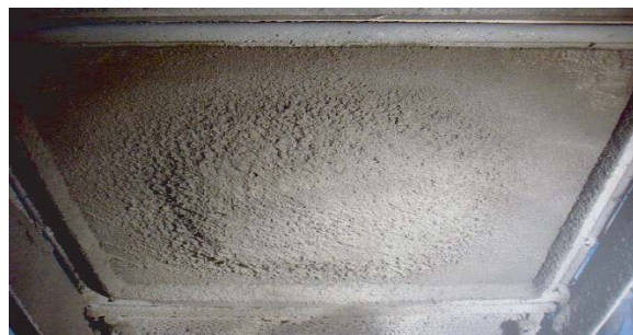
(b) 上向き吹付け
