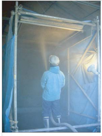
写真－2.3 上向き吹付けの状況
