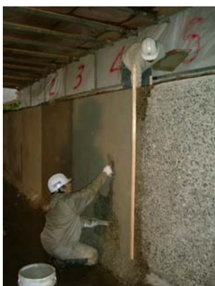
写真-4 断面修復工
