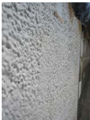
写真-10 劣化部除去面に樹脂系被覆材を塗布した水路
