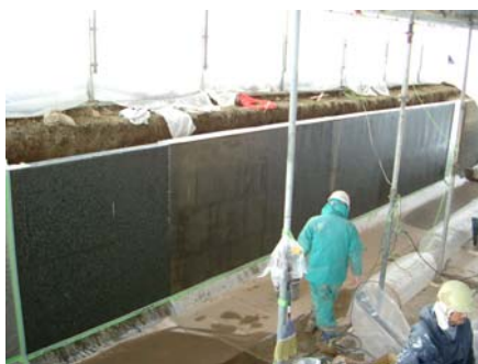
写真-5 プライマー塗布
