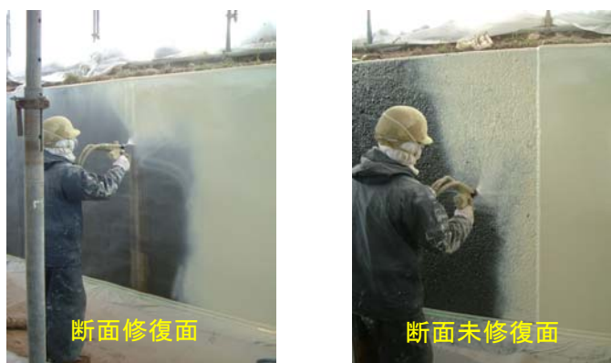
写真-6 樹脂系表面被覆材塗布
