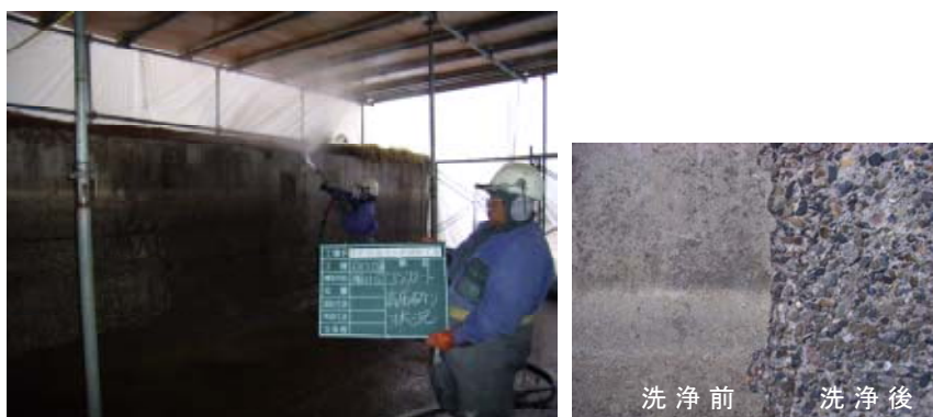
写真-3 劣化部除去工
