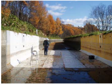
写真-7 施工後の状況 (2007. 11)
