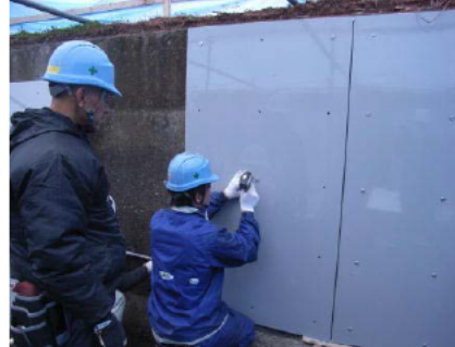
アンカー打込み
