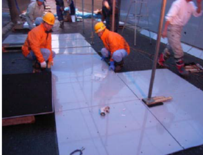
FRPM板の設置
