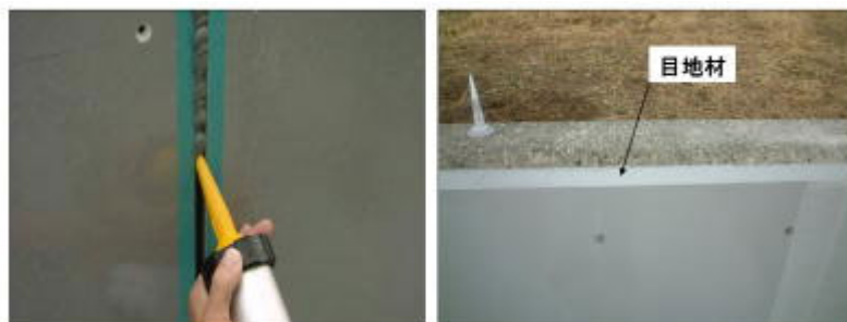
写真-1 目地材によるシーリング箇所
