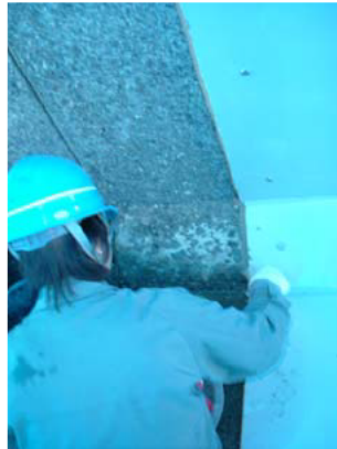
写真-6 小口部の処理（下流側）
