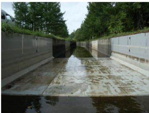
写真-7 施工完了後の状況
