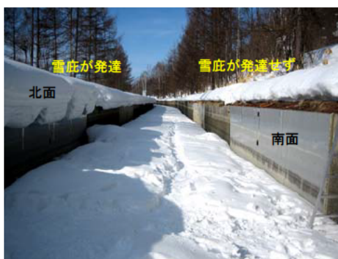
写真-9 冬期の試験施工区間の状況
